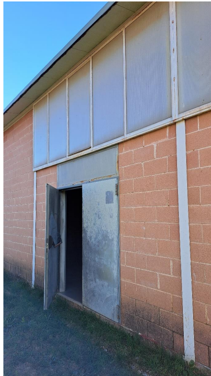
Obertures i porta d'emergència de la façana lateral
