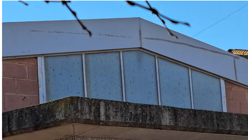
Obertures de la façana davantera
