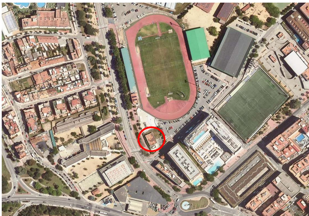
Figura 1. Situació de l'EBAR Central de Lloret
