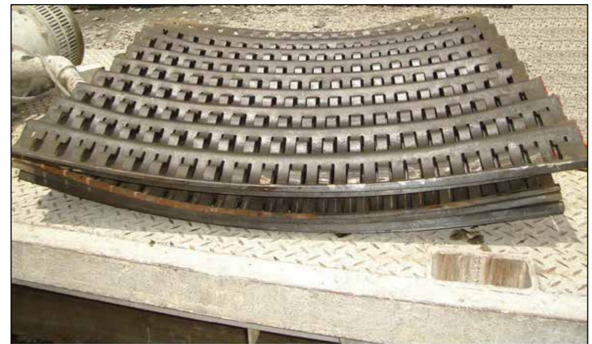
FOTO 3 : PLANXA BERNOLD CORBADA SEGONS EL RADI DEL TUNEL
