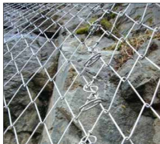
Malla TECCO® fabricada con alambre de acero de alta resistencia con los extremos anudados sobre sí mismos.
