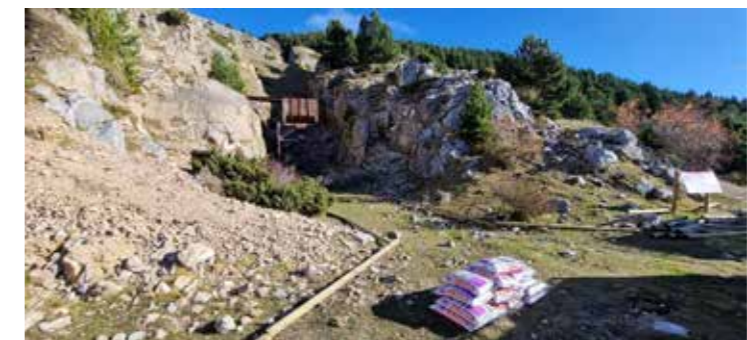
Procés de construcció de la tanca a la mina de la Bòfia
