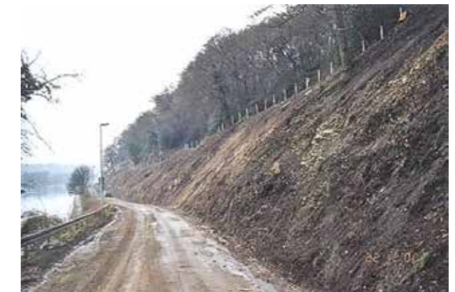
Medidas de preparación del terreno (limpieza, desbroce, cortes parciales, etc.)
