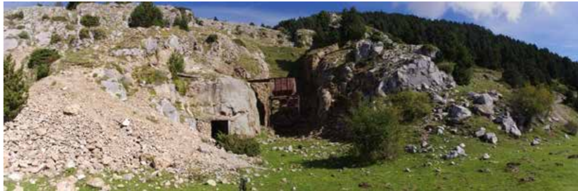
Figura 1 Fotografia de l'estat actual de l'exterior de la mina
