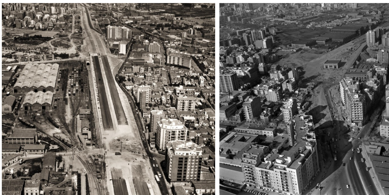
Figura 1. Imatges de la construcció de l'Avinguda Meridiana.
