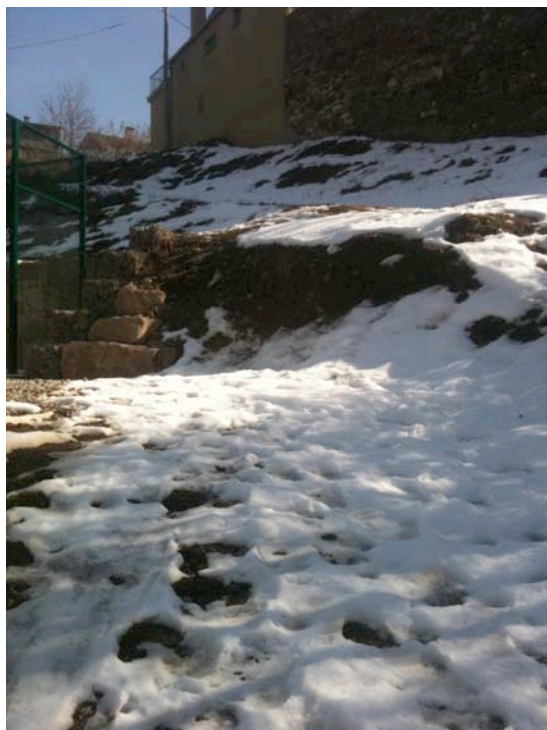
FOTOGRAFIA 1. Aflorament del dipòsit col·luvial quaternari (sorres i gravetes llimoses) en el vessant natural.
