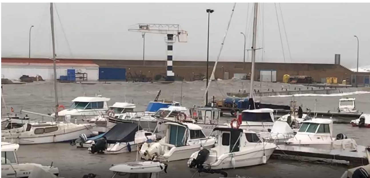
Imatge 3 Onatge durant el temporal en la zona del moll de la benzinera y moll pesquer. S'observa com la onada ultrapassa tant el moll de la benzinera com el pesquer
