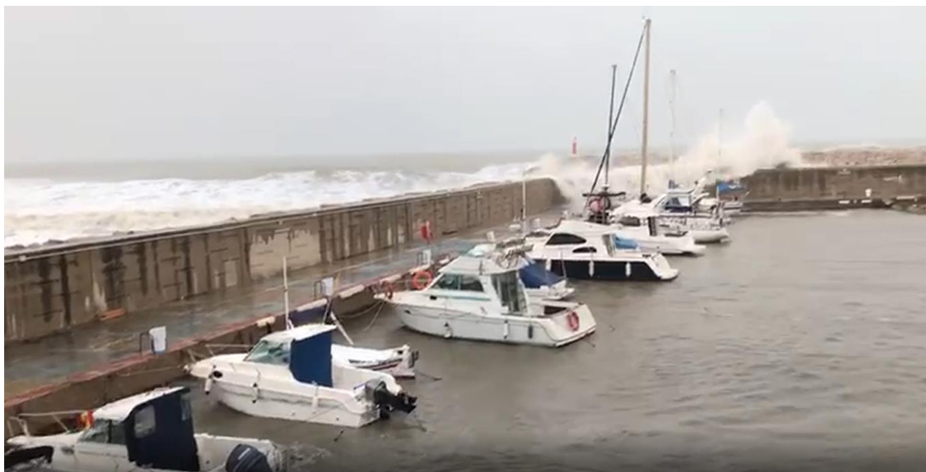
Imatge 1 Ultrapassament sobre el contradic durant el temporal Glòria de Gener de 2020
