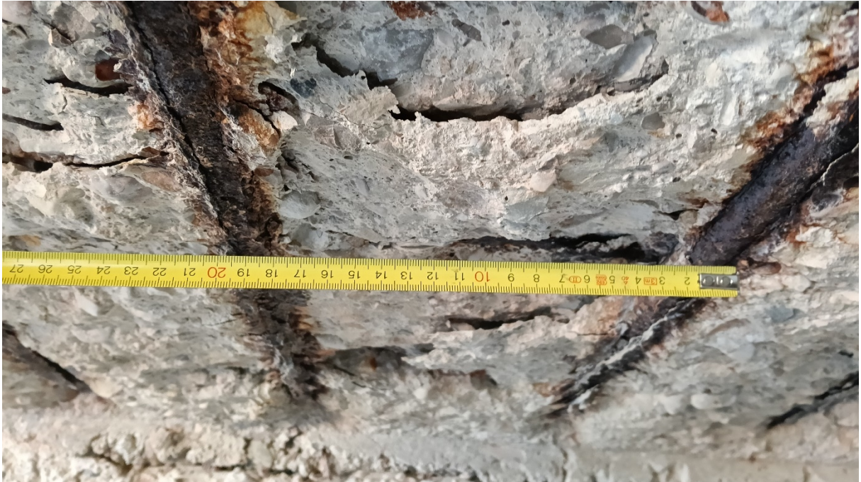
Fotografia 3. Separació entre barres de l'armat longitudinal inferior de la llosa superior (20cm).
