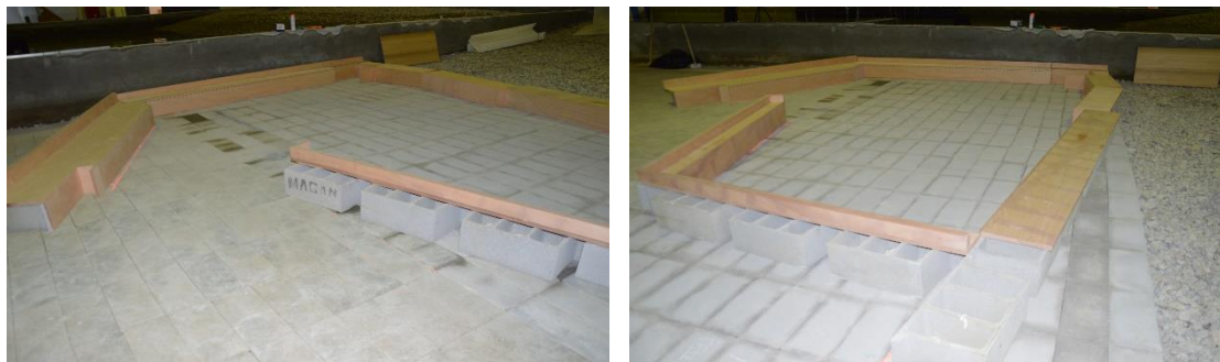
Figura 35 Construcció dels molls interiors del port de Les Cases d'Alcanar
