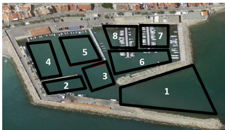
Figura 55 Ubicación de las sondas de oleaje colocadas en el modelo físico para la medición de la agitación interior
