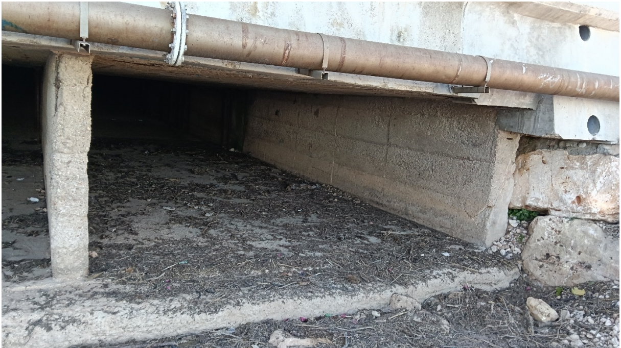
Fotografia 1. Ull esquerre del marc vist des d'aigües avall. Es pot veure la biga-muret i el seu recolzament sobre l'escullera, no sobre el propi marc.
