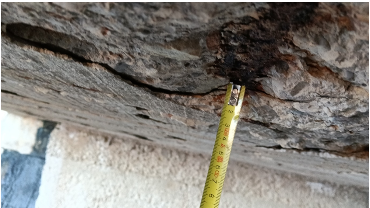
Fotografia 4. Gruix del recobriment geomètric de l'armadura anterior (2cm).
