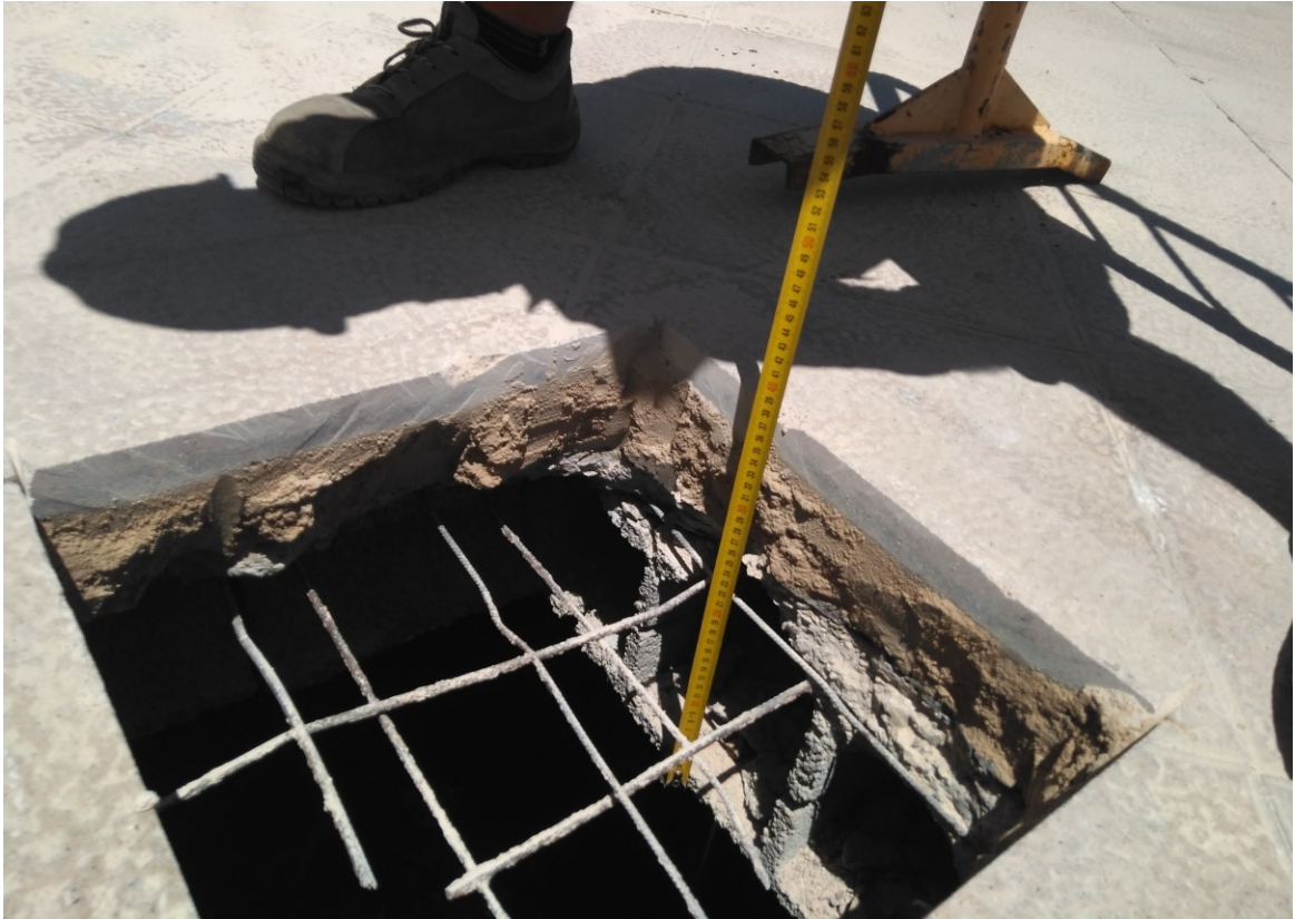
Fotografia 8. Cala feta sobre el Tram 1, a prop de l'obra de pas. Es pot apreciar clarament la secció del cobriment, pròpia d'un forjat d'edificació, així com el gruix de sorra molt humida.
