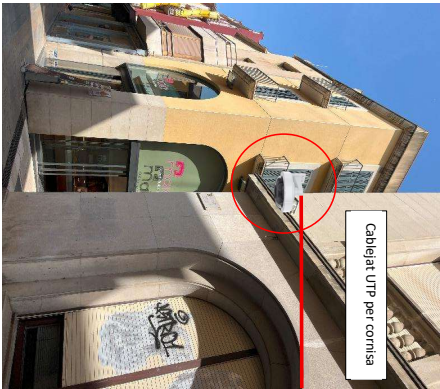
Il·lustració 57: Recorregut cable parells trenat PdC-07
