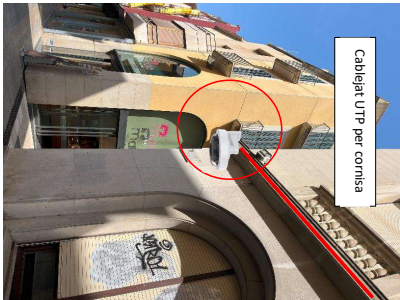
Il·lustració 58: Recorregut cable paretls trenat PdC-08
