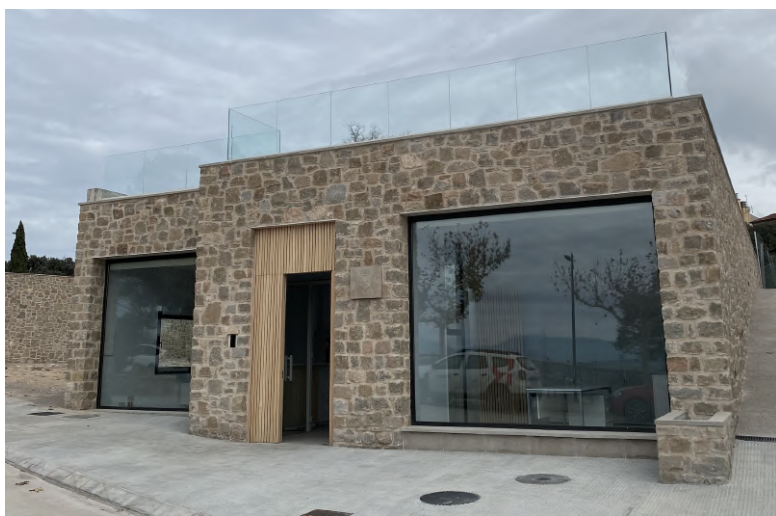
Volum executat finalització de la fase 1
