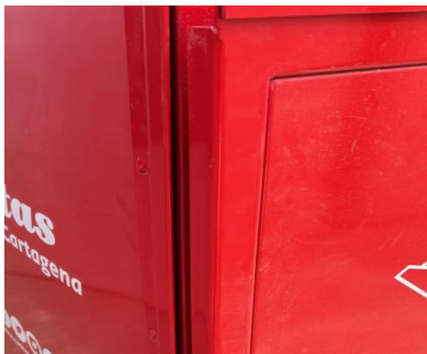
DETALLE PUERTA DE SERVICIO CON DOBLE PARED Y MARCO REFORZADO DE 2 Y 3MM.
