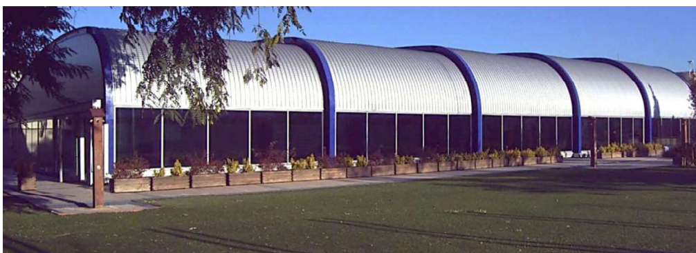
Fotografia 3: Vista exterior de la coberta mòbil tancada
