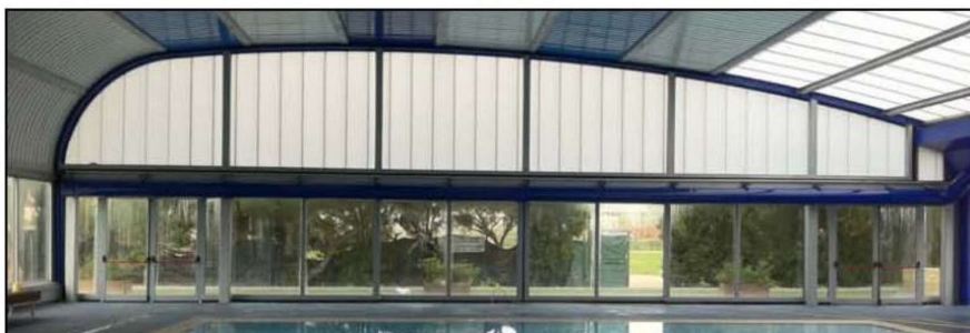
Fotografia 10: Fusteries lliscants tancades
