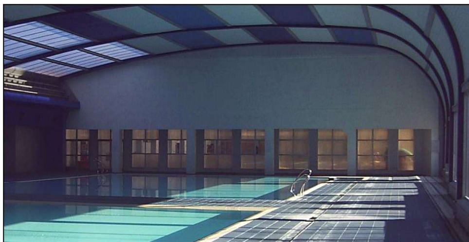
Fotografia 12: Façana del edifici de la piscina coberta
