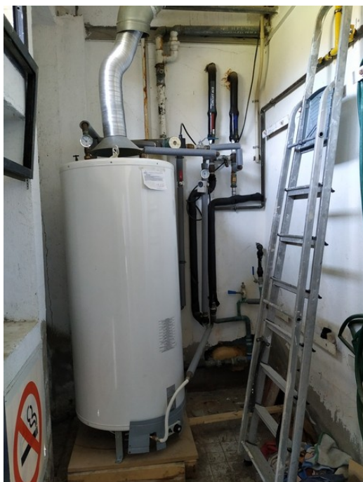
Imatges 3 i 4.- Dipòsit ACS i placa característiques
