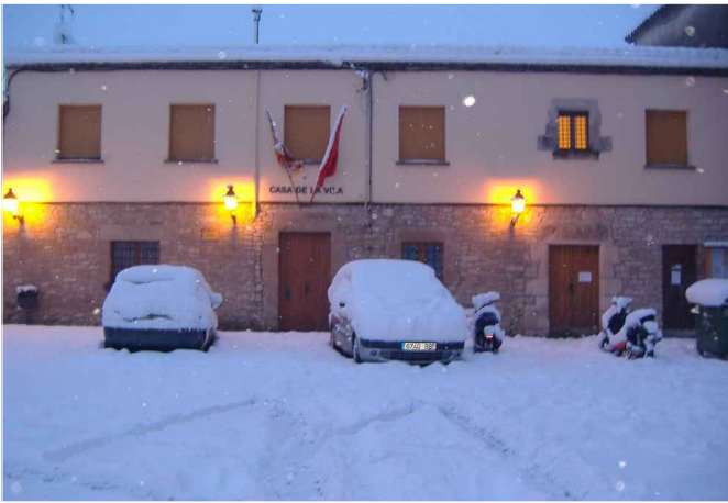
IMATGE 11 FAÇANA FRONTAL Font: Ajuntament de Calders. Gener 2006
