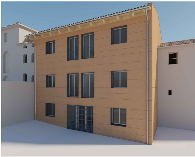
IMG.02 VISTA A FAÇANA POSTERIOR C.CAMÍ DEL CARGOLAIRE S/N
