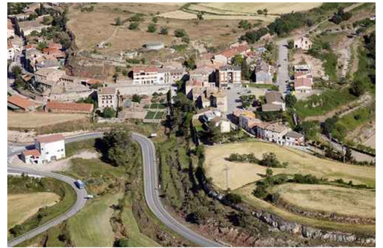
IMATGE 02 VISTA D'OCELL DES DE L'EST Font: Ajuntament de Calders
