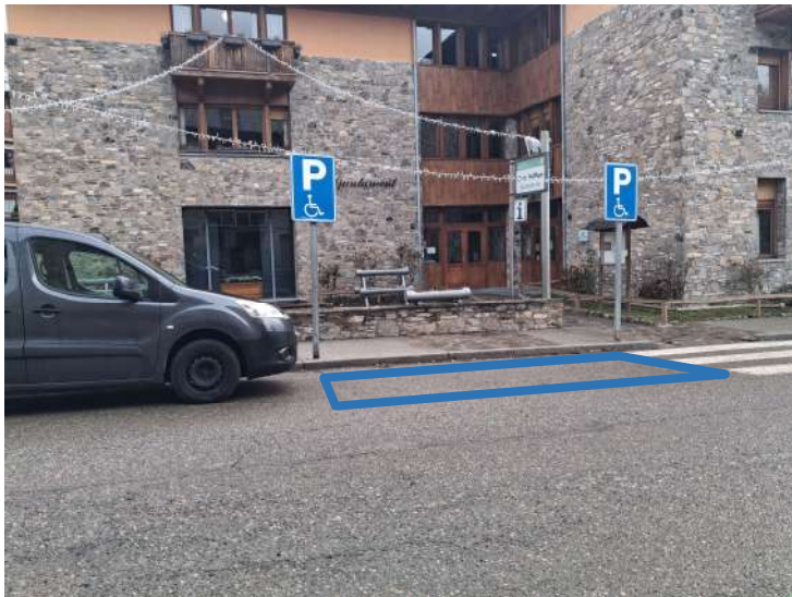
Imatge 6. Al centre del poble s'hi han senyalitzat dues places d'aparcament reservades però cap de les dues es troba completament indicada ja que només compten amb senyals verticals i no s'hi ha delimitat el límit de la plaça amb senyalització horitzontal.
