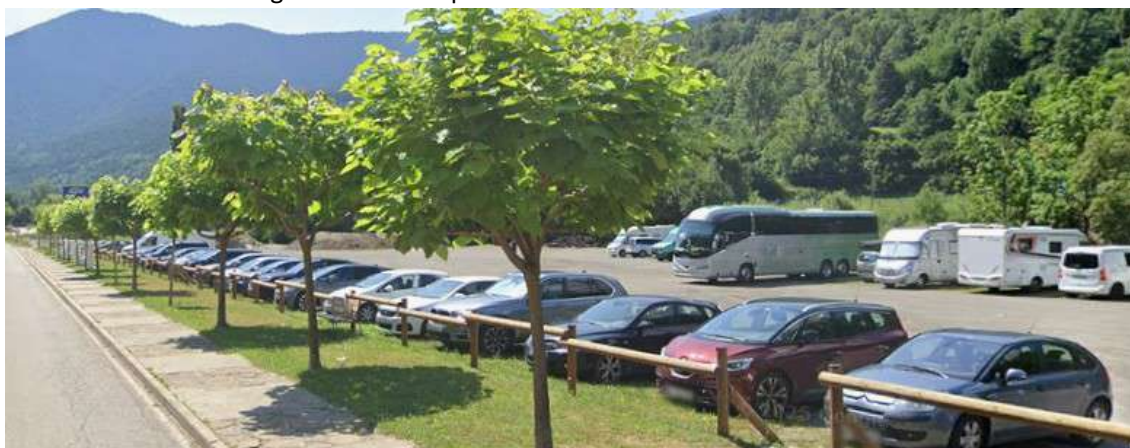
Imatge 5. L'aparcament dissuasiu de l'entrada no compta a cap tipus d'il·luminació.
