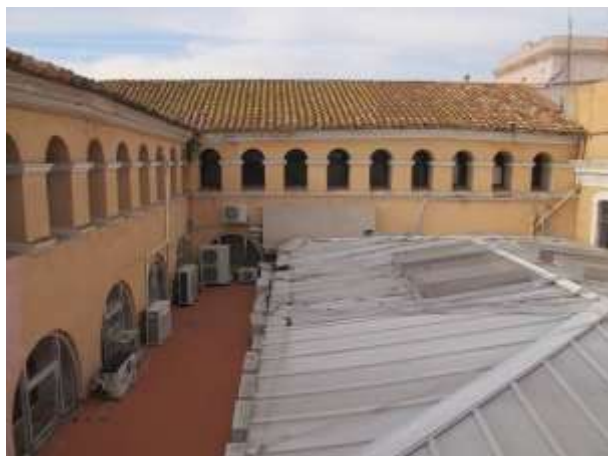
Vista actual de l'estat que presenten les façanes interiors del pati amb les sèries d'arcuacions de mig punt que s'obren cada planta que es corresponen amb les de l'antic claustre del convent.
