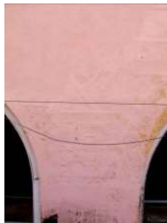
Detall del revestiment dels murs del claustre on s'aprecien les restes dels esgrafiats originaris.
