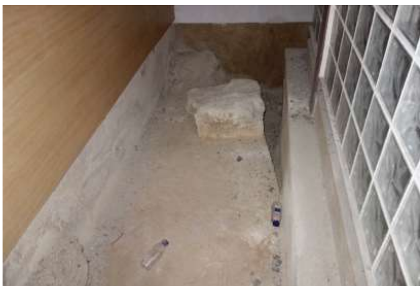
Restes del basament d'un dels arcs de les càrceres localitzat l'any 2006 i actualment conservat a l'edifici del Palau Municipal
