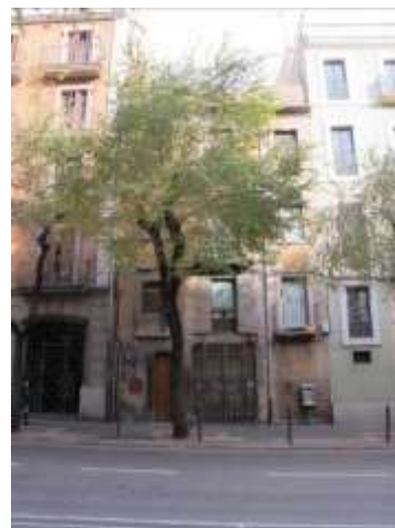
Edifici finca núm. 49
