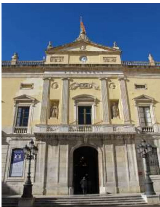
Vista del cos central de la façana principal de l'edifici del Palau Municipal.
