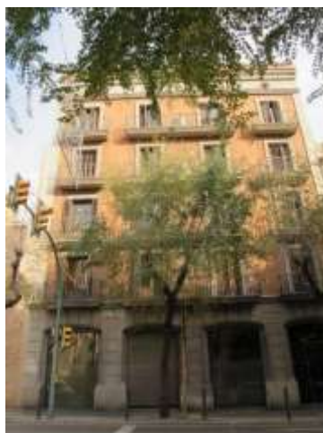
Edifici finca núm. 51
