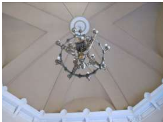
Detall de la cúpula de gallons que cobreix l'estança octogonal.
