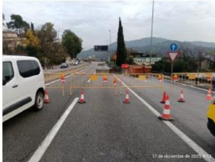
C-17 PK 3+000 Calçada dreta tallada
