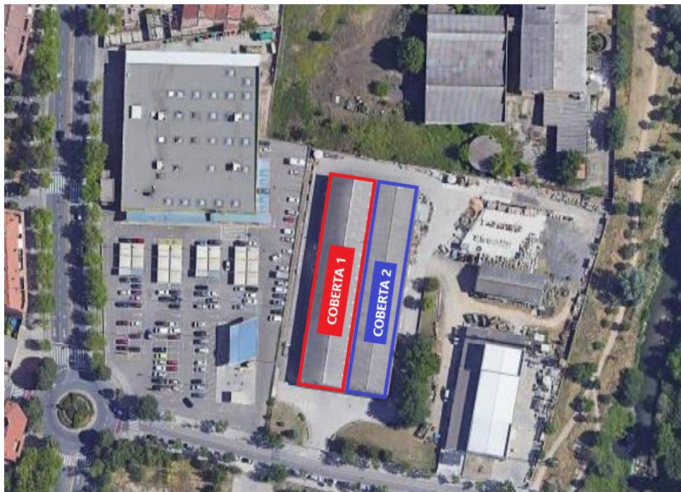
Figura 1 – Vista general de les instal·lacions de XARXES DE SERVEIS URBANS de Vic, on s'indiquen les cobertes de l'edifici. La coberta 2, de formigó prefabricat, queda fora de l'abast de l'informe
