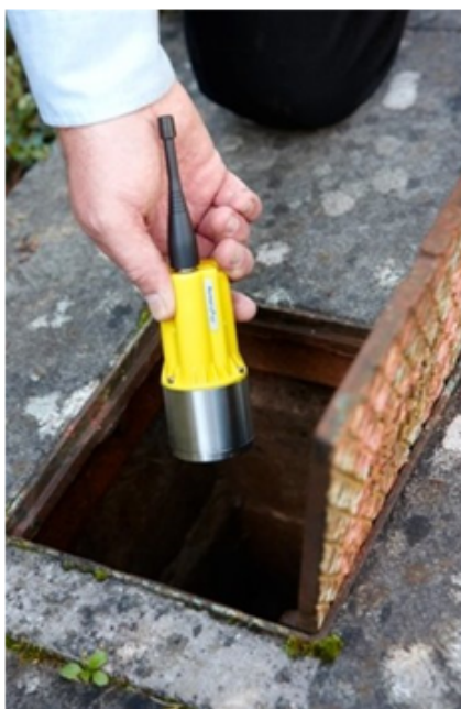
imatge 5: Instal·lació de sensor permalog
