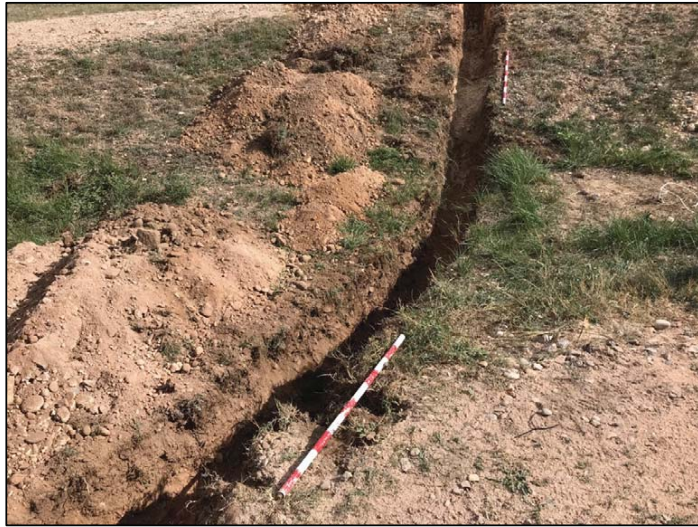
Figura 10. Imatge de la rasa elèctrica excavada a l'exterior de la torre afectat un estrat de terres superficials
