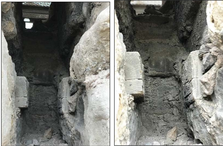
Figura 7. Detall de les entrades al mur sobre la porta amb el encaixos de fusta que recollien les cordes o cadenes per elevar el pont llevadís
