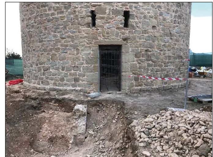
Figura 6. Sobre l'entrada a la torre se situen dues obertures o entrades en el mur per recollir les cadenes o cordes que elevaven la plataforma del pont llevadís
