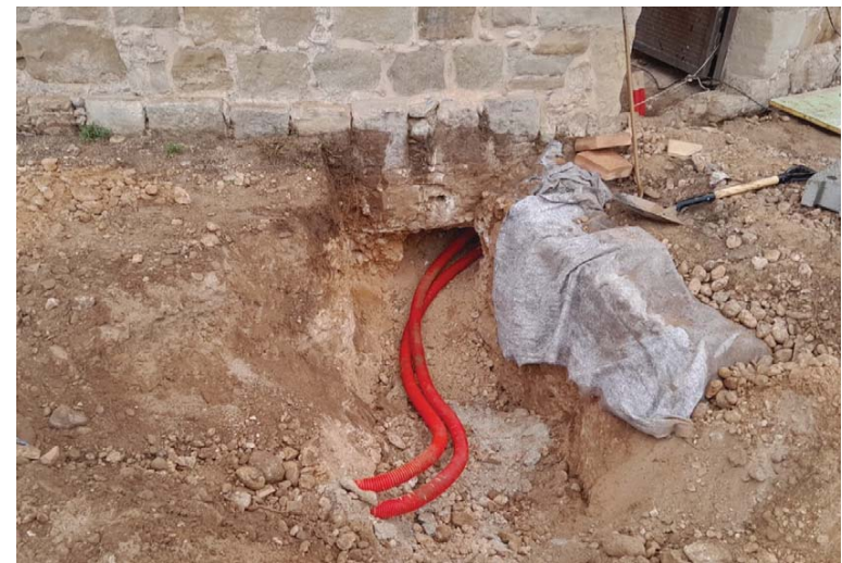
Figura 9. Instal·lació dels tubs d'enllumenament, per sota de la fonamentació de la torre.
