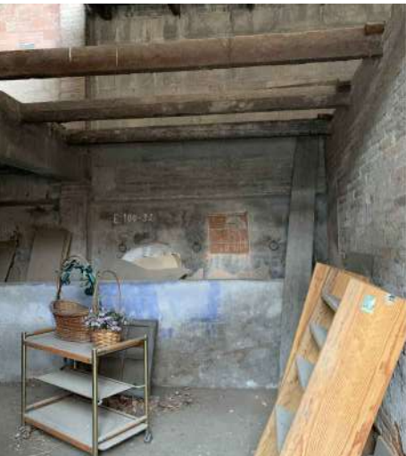
Estable cavalls Cos annex al pati amb menjadores. Forma part parcialment de la planta baixa de l'antic paller (edifici dels arcs).
