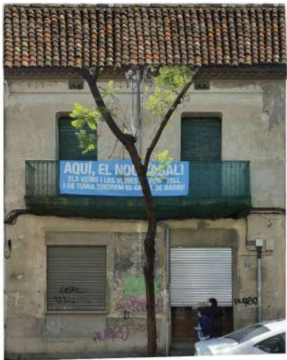
Façana exterior Casa Principal Mur de càrrega existent de paredat amb morter de calç de 42cm de gruix i amb obertures definides per maó, adintel·lades senzilles sense elements d'emmarcament. Acabat estucat llis en planta primera i arrebossat parcialment en planta baixa.
