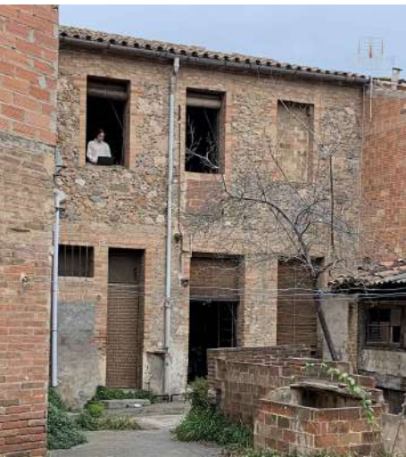
Façana interior Casa Principal Mur de càrrega existent de maçoneria de pedra i morter de calç, de 45cm de gruix, sense acabat i amb obertures definides per maó.
