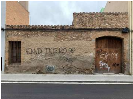
Façana exterior C/ Dr. Gil Mur de façana existent de paredat parcialment arrebossat de ≈35cm i amb obertures definides per maó.
