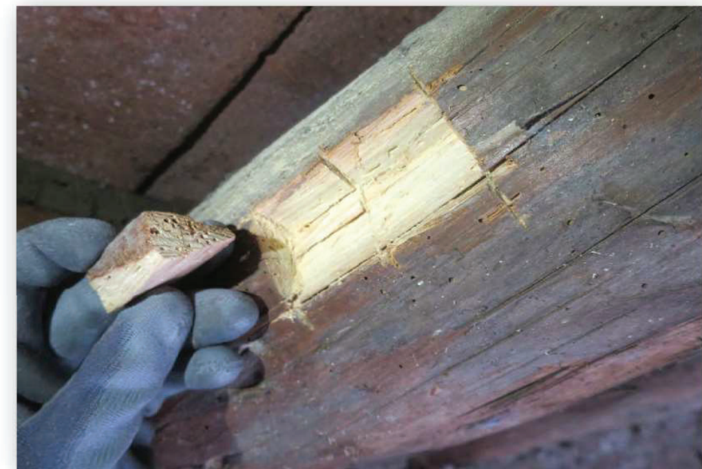
Sostre de la planta 1 (P1). Element P1C6. Imatge 459 Extracció d'una mostra de fusta
