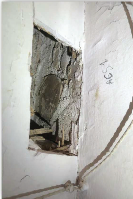
Sostre de la planta baixa (P8). Cala ACS1. Element PBA8. Imatge 360 Vista de la cala
