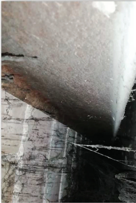
Sostre de la planta baixa (P8). Element PBA6. Imatge 407 Element ocult pel cel ras Perfil metàl·lic al costat de la biga
