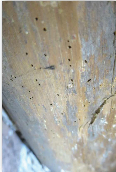
Sostre de la planta baixa (PB). Cala ACS1. Element PBA8. Imatge 365 Forats de sortida de còrrecs de petita grossària
