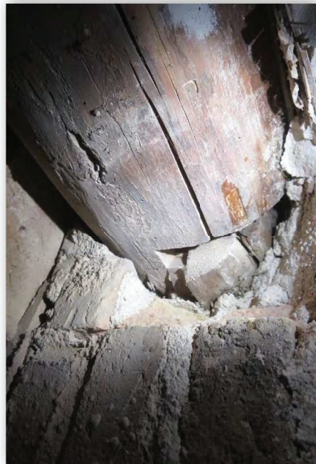
Sostre de la planta baixa (PB). Cala ACS3. Element PBB4. Imatge 358 Detail del recolzament de l'element
