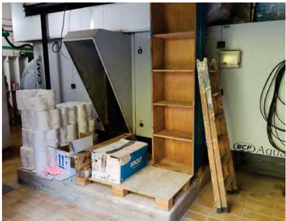
2 Ampliació d'obertures existents de ventilació deshumectadora
