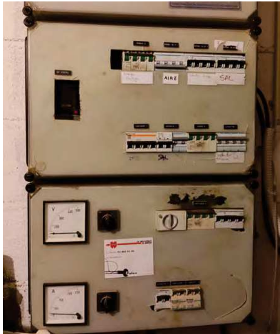
3 Desmuntar instal·lació elèctrica existent i Subquadre elèctric
