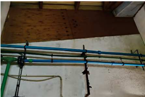
6 Obertures per noves reixes i conductes de ventilació
