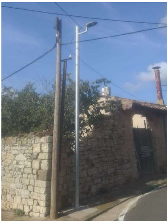
Imatge 1. Fanal ja renovat a Tordera.
