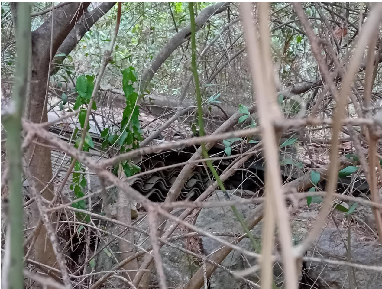
Fotografia 9. Plaques de fibrociment a retirar.
