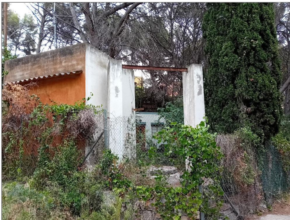
Imatge 4. Edificació localitzada dins l'àmbit d'estudi. Data: 09/07/2025.
