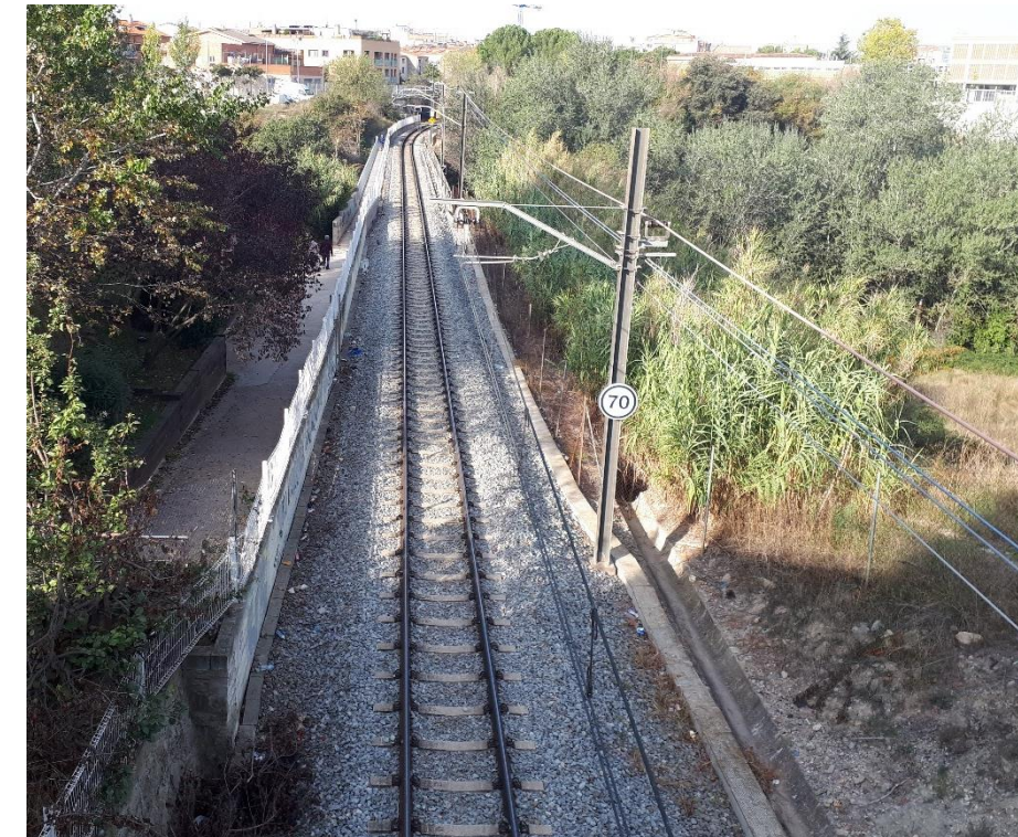
Figura 6. Estat actual infraestructura ferroviària sobre pont riera d'Òdena. Font: Elaboració pròpia
