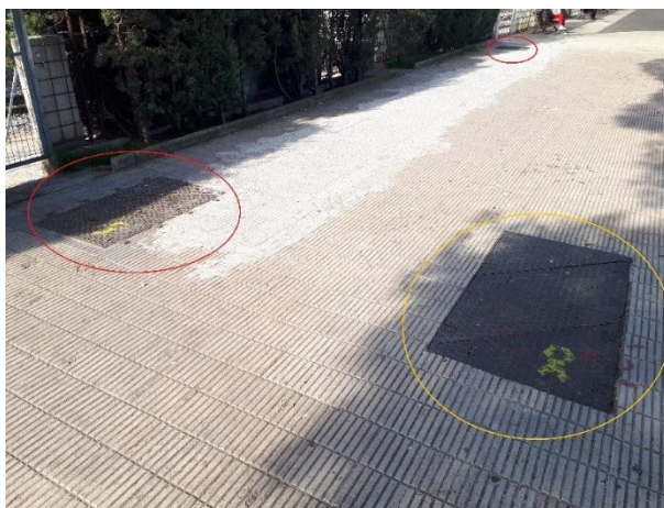
Figura 91. Registres canalització CTTI (identificades en vermell).
