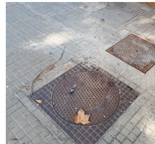
Figura 89. Registre cambra de canalització fibra òptica d'Orange Passeig Mossèn Jacint Verdaguer.
