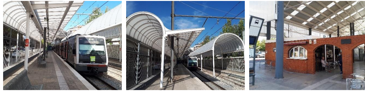
Figura 3. Estat actual estació d'Igualada (font: pròpia).
