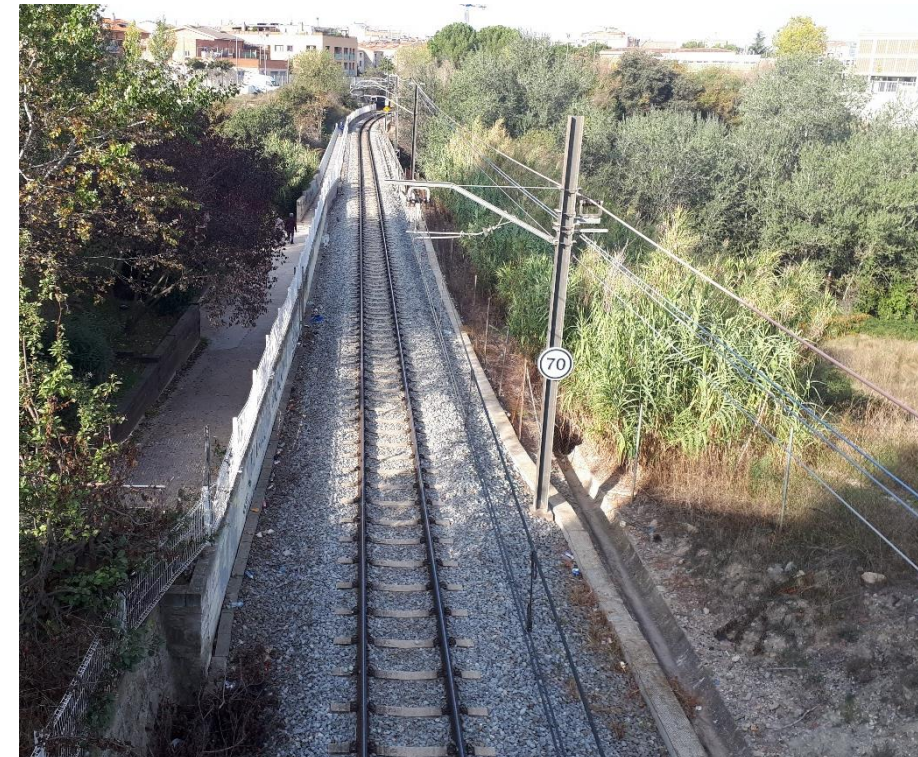
Figura 6. Estat actual infraestructura ferroviària sobre pont riera d'Òdena (font: pròpia).
