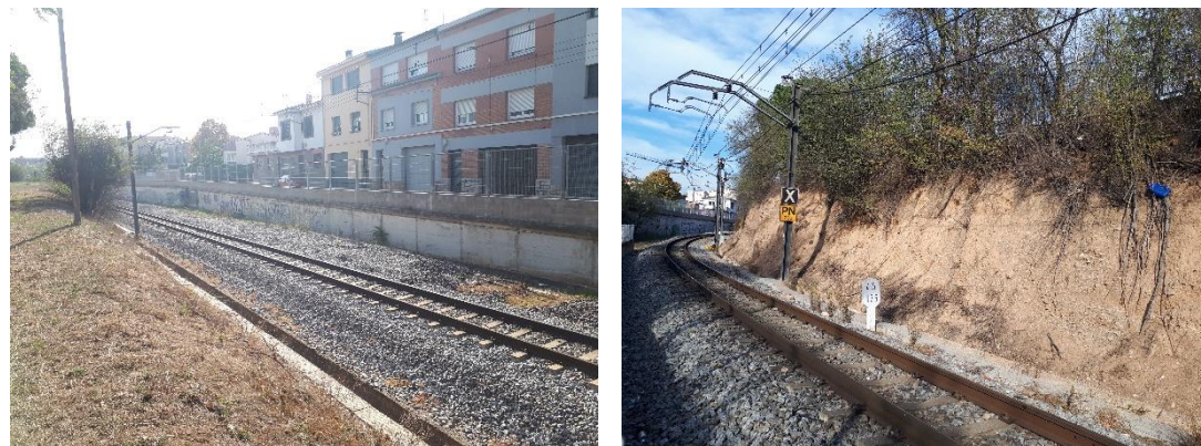
Figura 5. Estat actual infraestructura ferroviària (font: pròpia).
