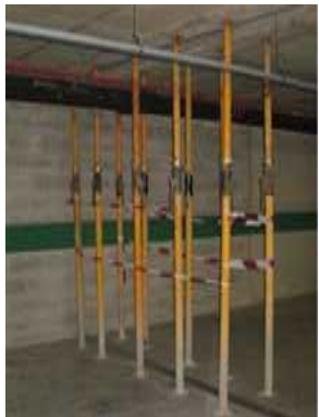
PROPOSTA REFORÇ AMB PUNTALS PER AL RECORREGUT I ACCESSIBILITAT ENTRADA RMT 3T
