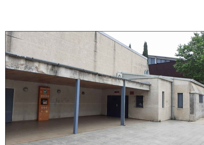
Enderroc per ampliació finestra
