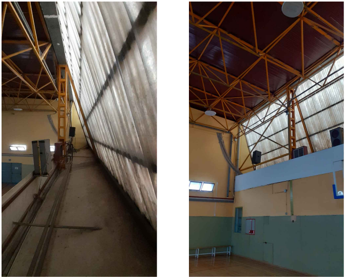
TANCAMENT EXISTENT DE PLACA ONDULADA DEL PAVELLÓ
