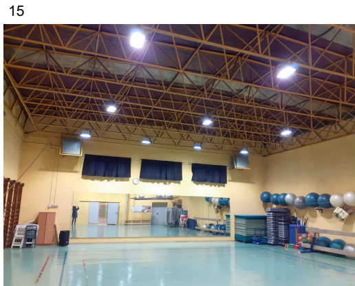
ZONA ACTUACIÓ GIMNÀS Actuació protecció foc amb fals sostre guix laminat EI60
