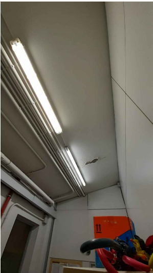
ZONA ACTUACIÓ COBERTA VESTIDOR ACTUAL PAVELLÓ Reparació coberta per solucionar humitats
