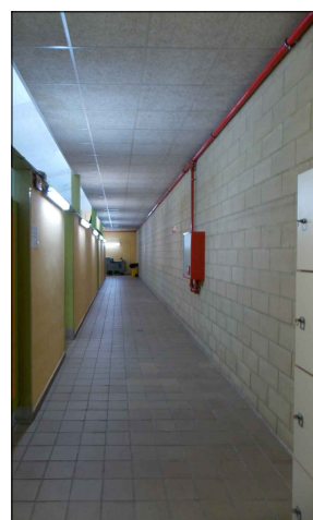
Façana passadís vestidors actuals - enderroc puntual per portes nous vestidors
