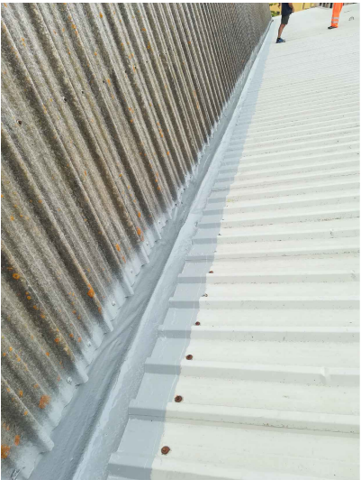
ZONA ACTUACIÓ COBERTA VESTIDOR ACTUAL PAVELLÓ Reparació coberta per solucionar humitats
