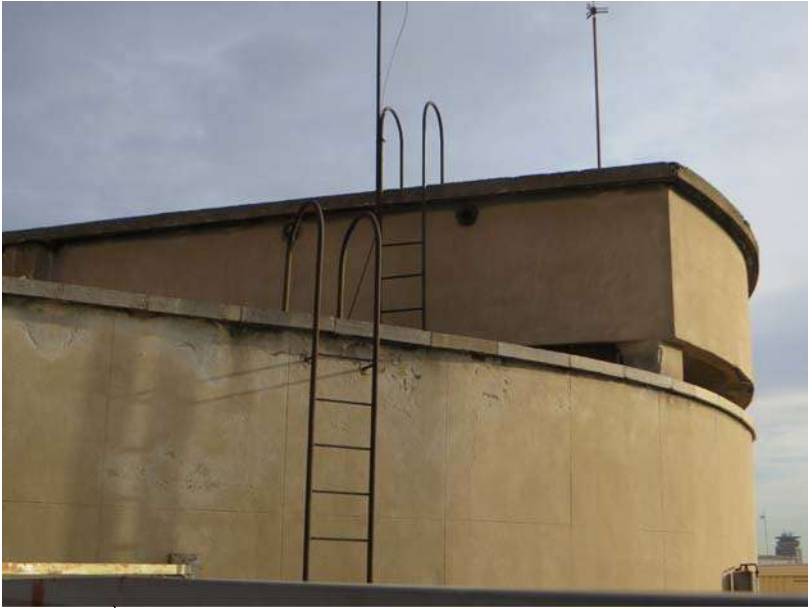
IMATGE DIPÒSIT A ENDERROCAR
