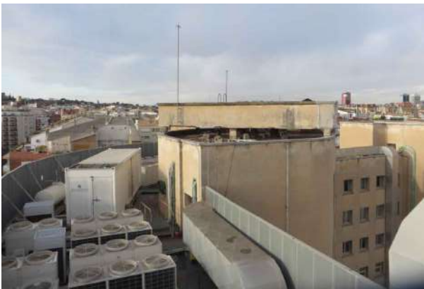
Estat actual. Coberta 4/5.
