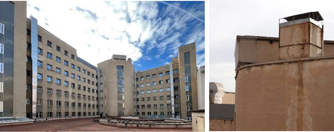
Vista general de la façana posterior i detall de la coberta del pati que mulla la façana
