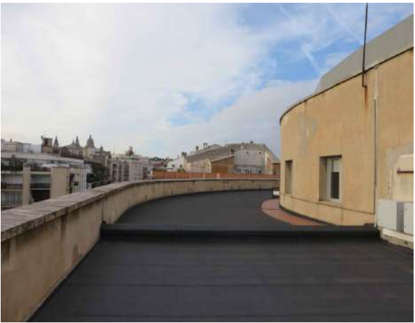
Estat actual. Coberta 3.
