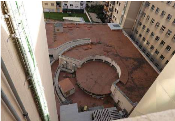
Estat actual. Coberta 1/2.
