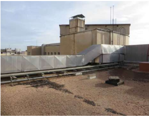
Estat actual. Coberta 4.
