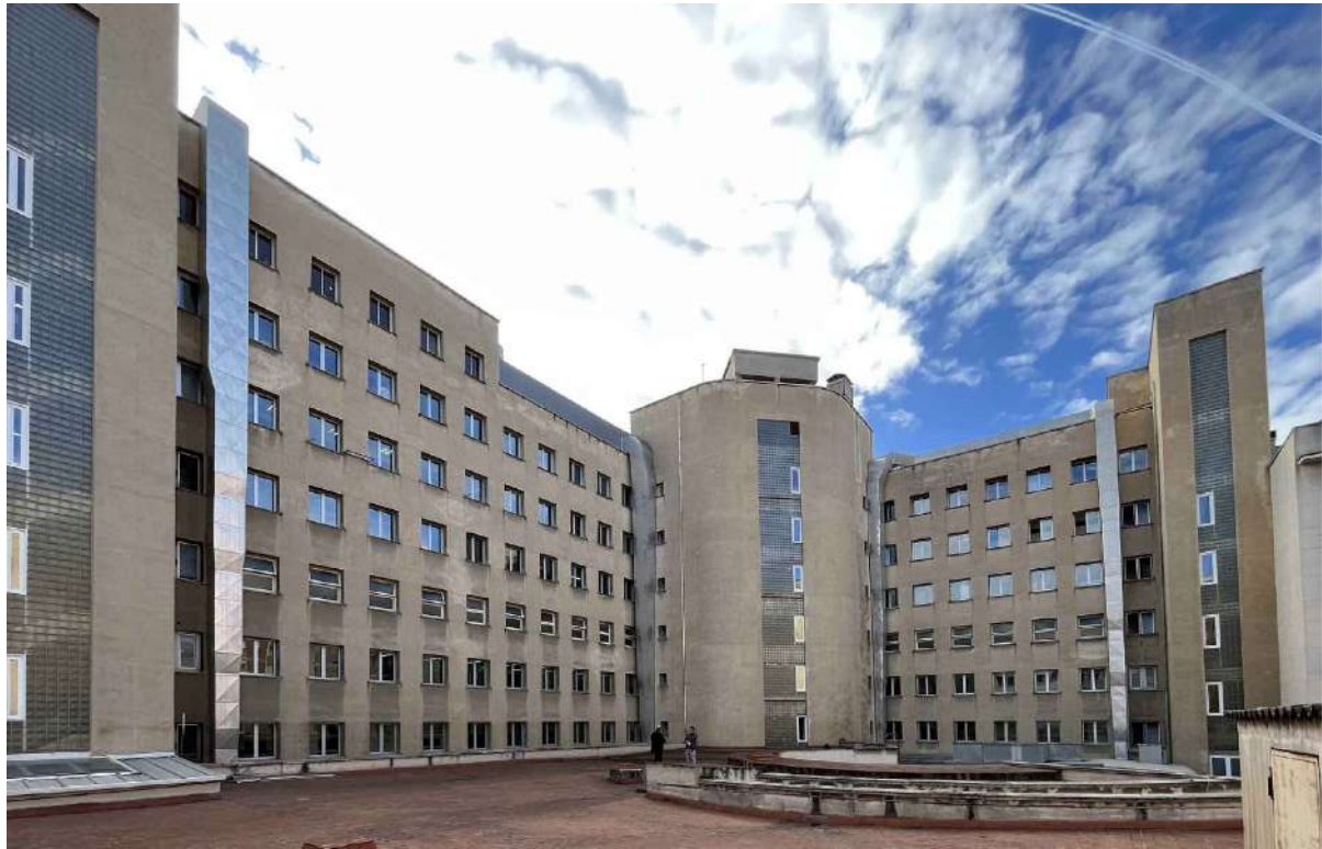
Estat actual. Façana posterior.
