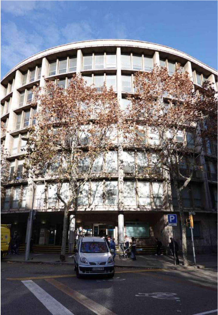
Estat actual. Entrada façana principal.
