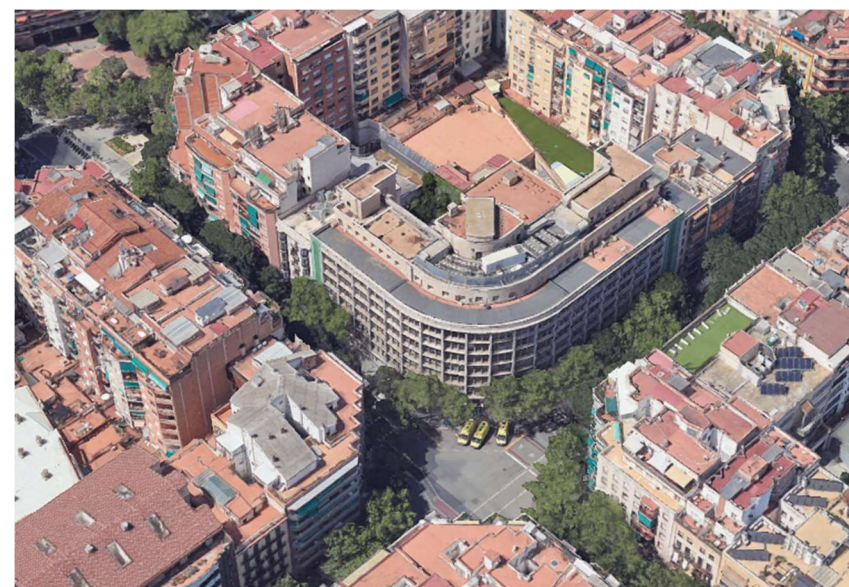
Il·lustració 1: Edificació industrial objecte d'instal·lació del sistema fotovoltaic. Font: Google earth
