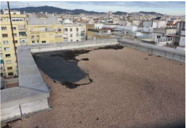
Estat actual. Coberta 5.
