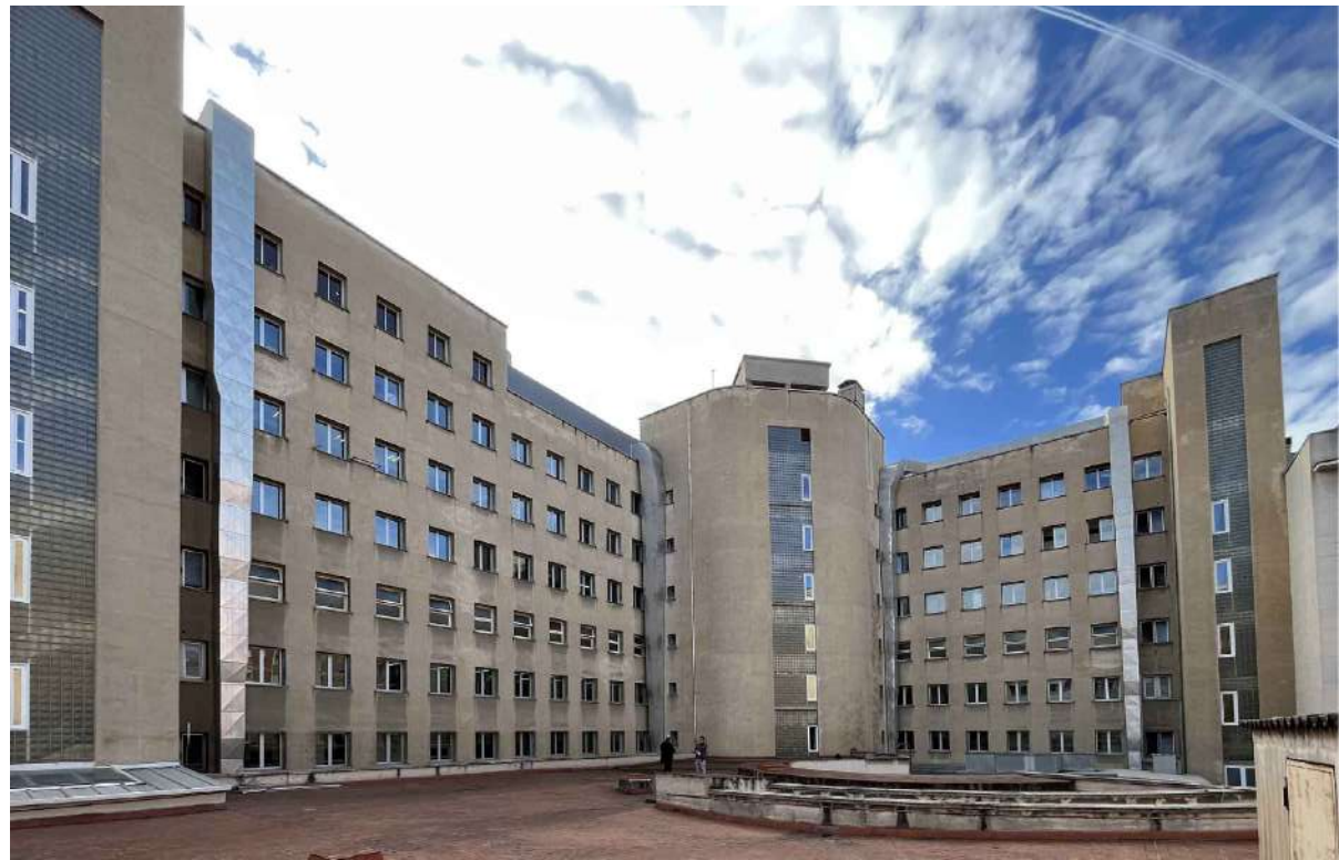
Estat actual. Façana posterior.
