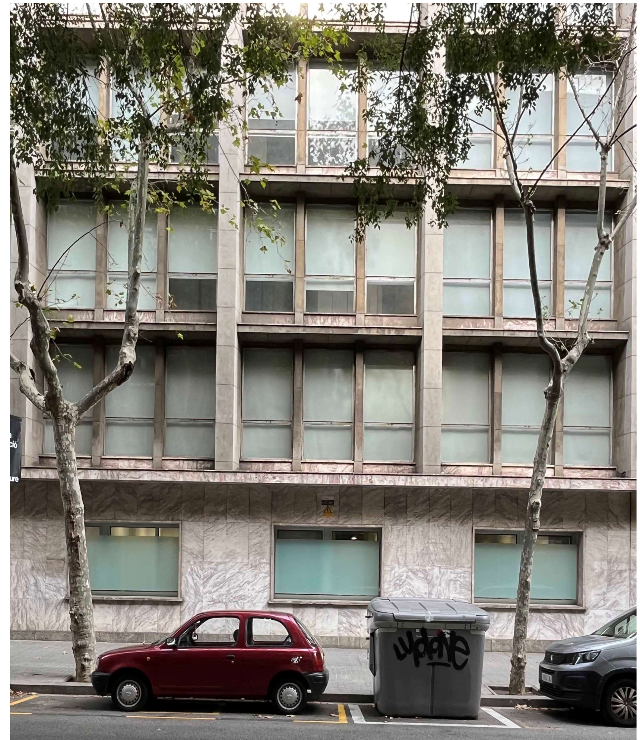
Fusteries de façana principal
