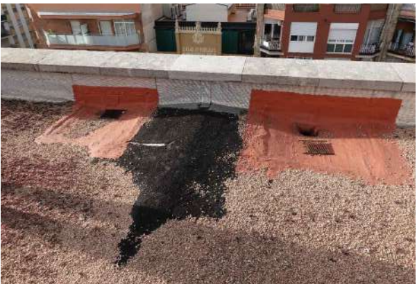
Estat actual. Coberta 4.
