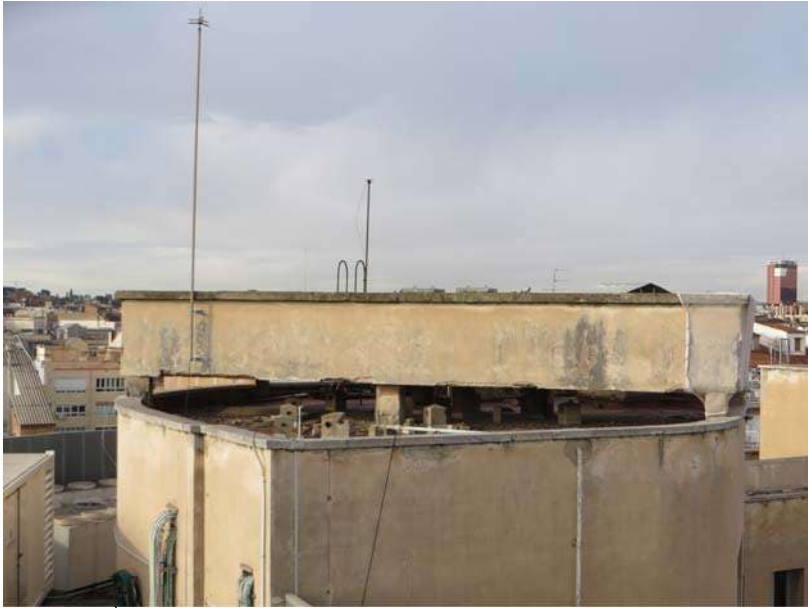
IMATGE DIPÒSIT A ENDERROCAR
