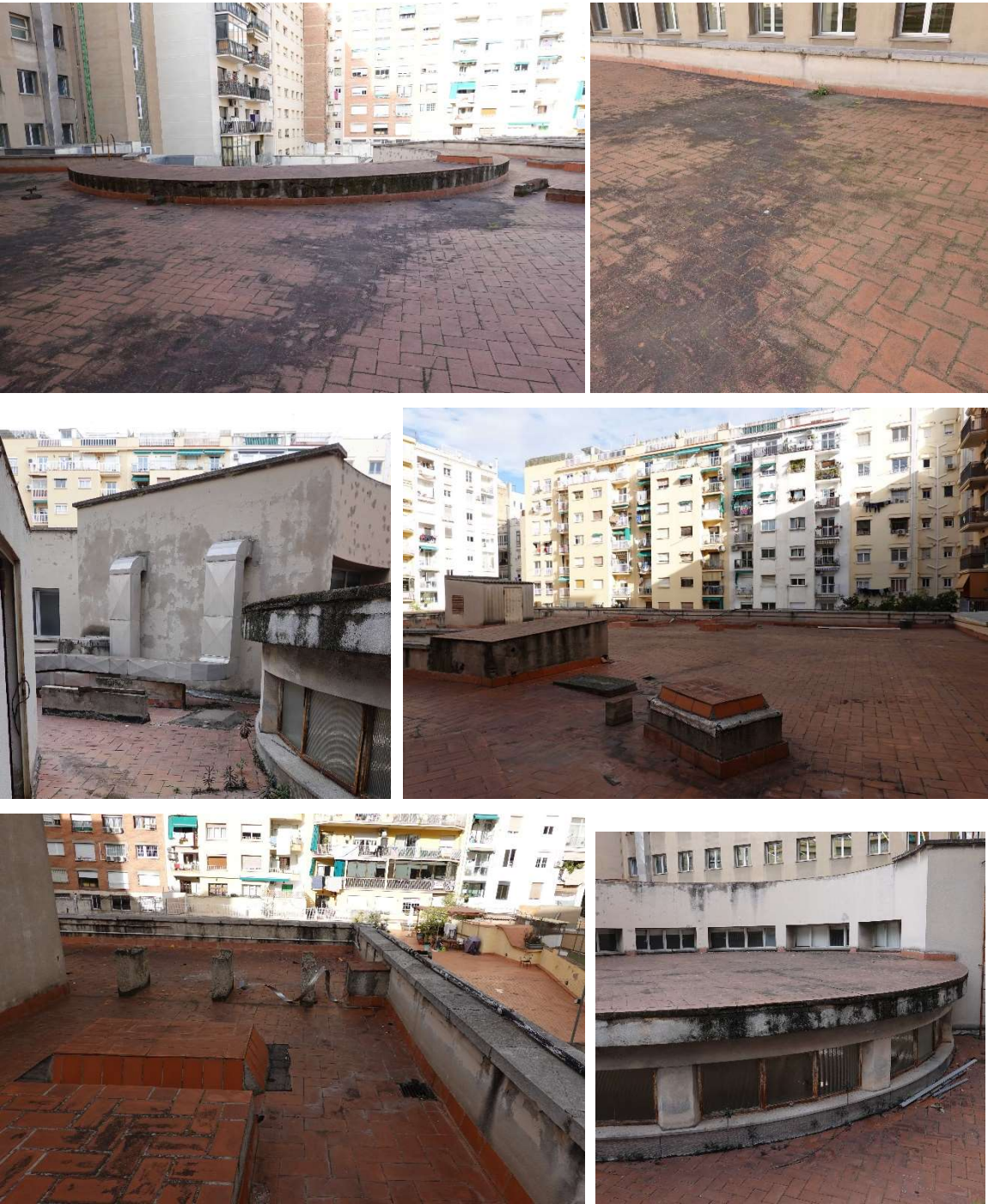
Detalls de la coberta de l'edificació interior d'illa, de forma general amb temes de manteniment, i puntualment amb elements a intervenir.
