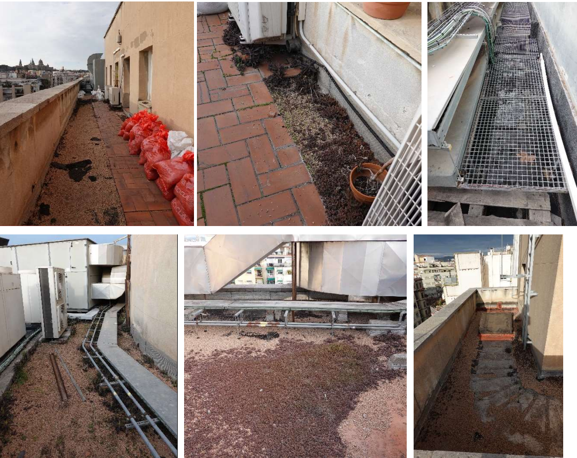
Detalls de la coberta a la planta vuitena (sostre de la planta setena). Biodipòsits, aigua i tela desprotegida
