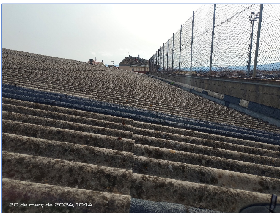
Vistes exteriors de la coberta 1
