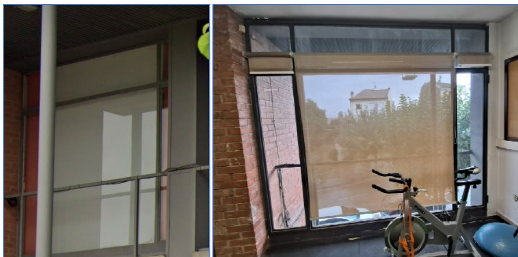
Fusteria P6 (exterior i interior)
