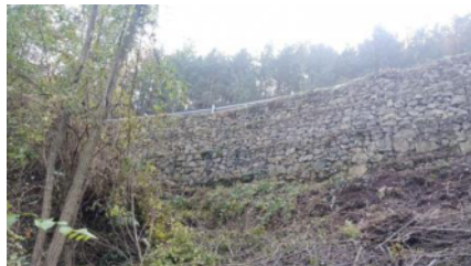
Mur de gabions
