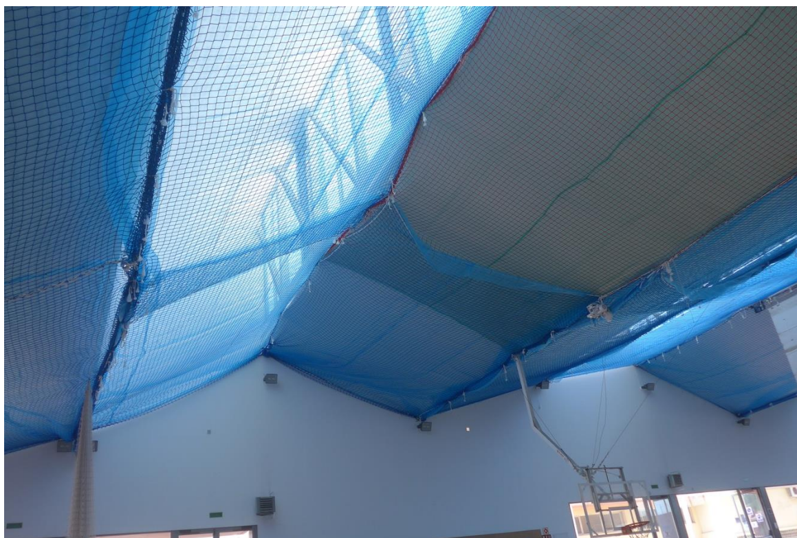
Figura A-17 Instal·lació de xarxes de protecció
