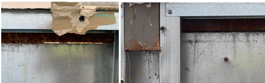
Figura PR-1 Fotografies des de l'interior del pavelló de les juntes obertes, muntants i cargols dels minvells
