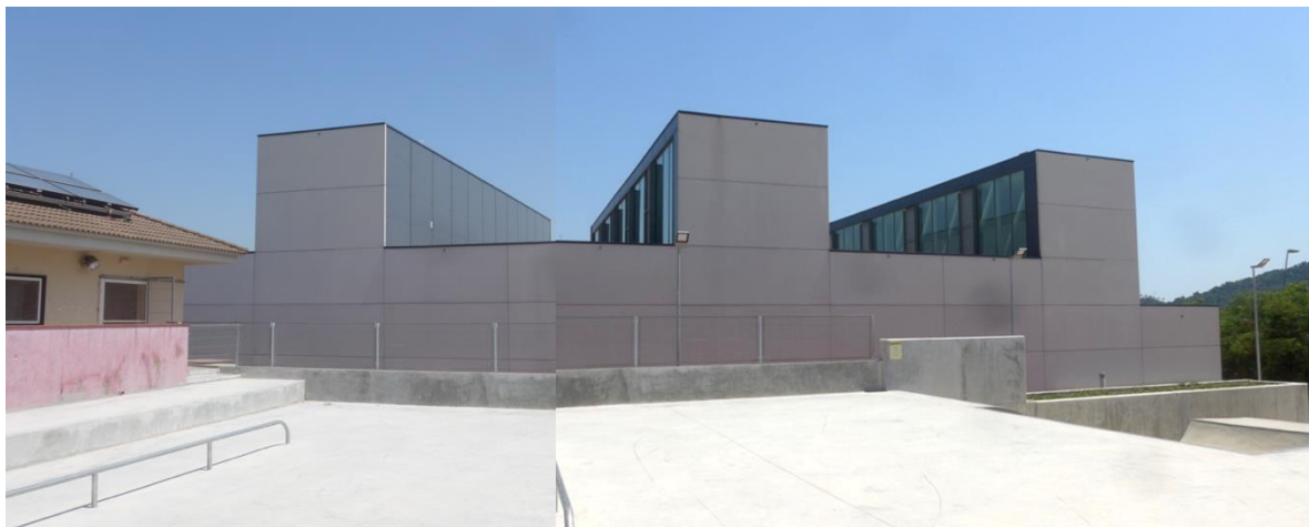
Figura A-2 Façana Oest
