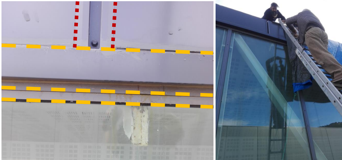
Figura A-14 Segellat de juntes obertes amb silicona
