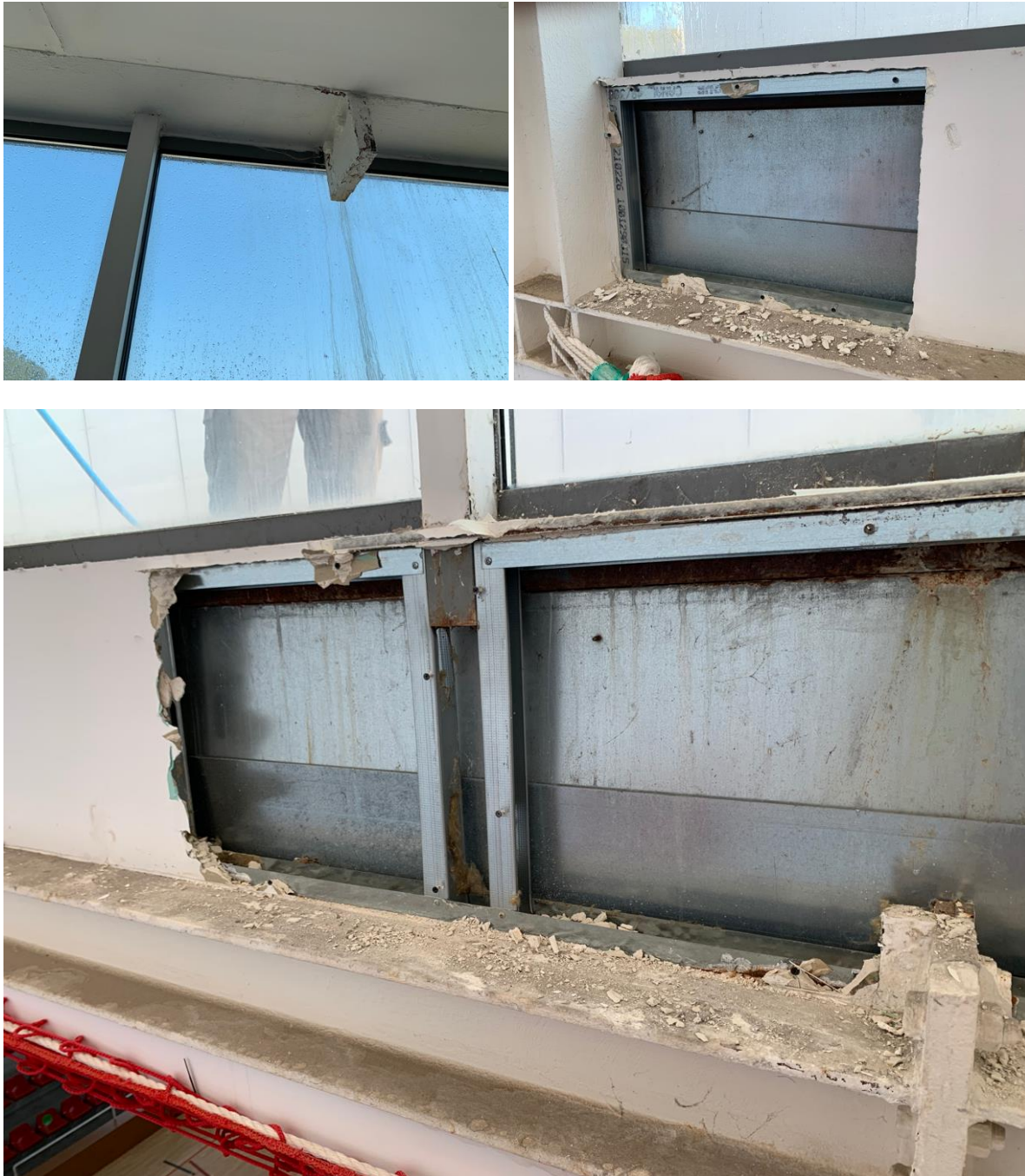
Figura RT-4 Fotografies fusteries des de l'interior
