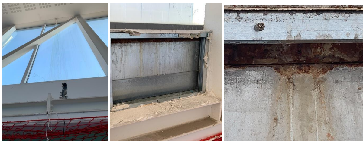
Figura RT-5 Fotografies de les cales interiors E2 i E2'
