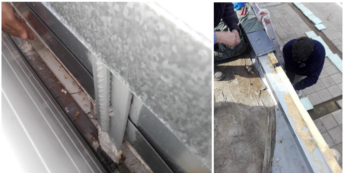
Figura A-15 Subestructura de façana
