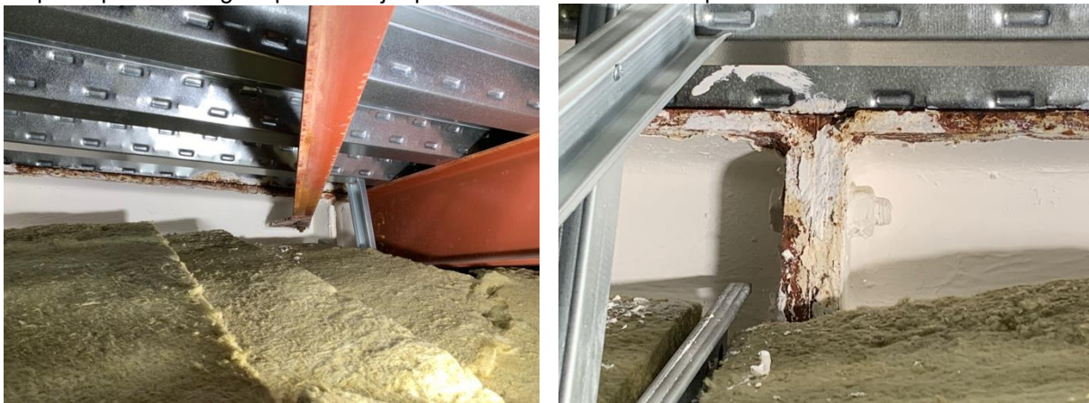
Figura RT-9 Fotografies dels perfils de coberta vistos a la Cala E1
