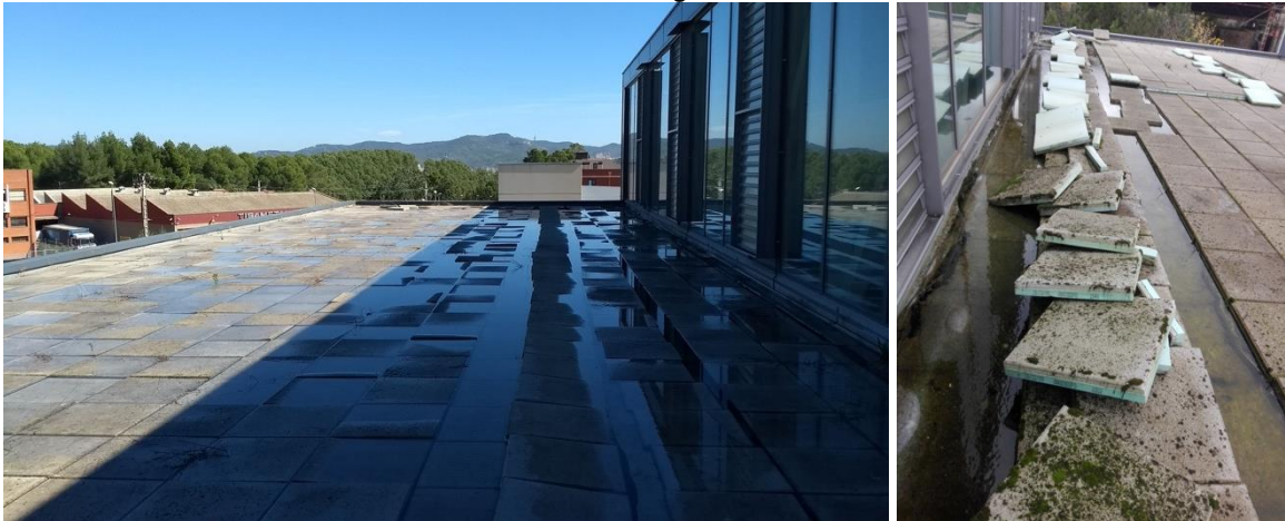
Figura A-12 Prova d'estanquitat i extracció de paviment
