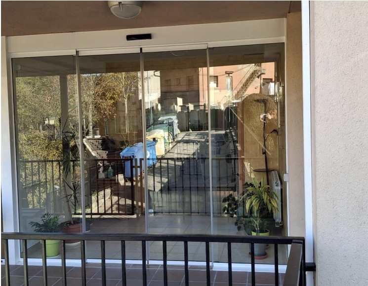
Porta d'entrada residència. Accés amb una porta de dues fulles. Vista exterior
