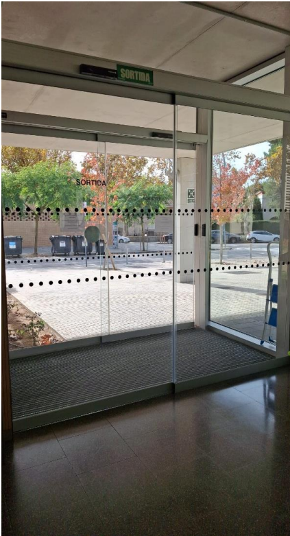
Portes d'entrada residència. Accés amb dues portes en paral·lel d'una fulla amb vidre fixe. Vista interior
