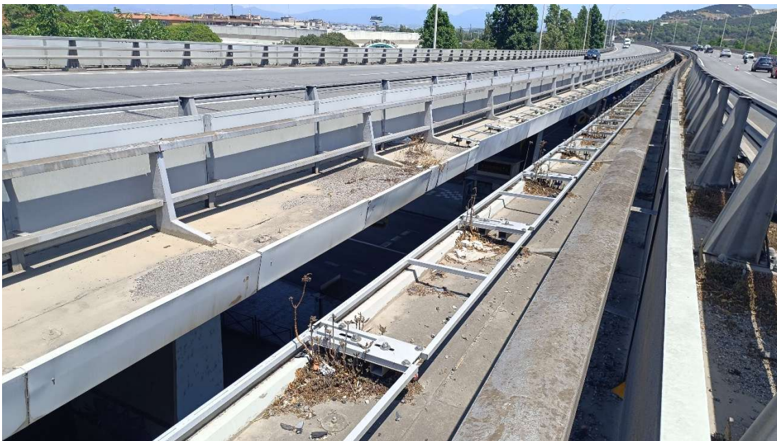
Imatge 18. Reforç estructural a les impostes
