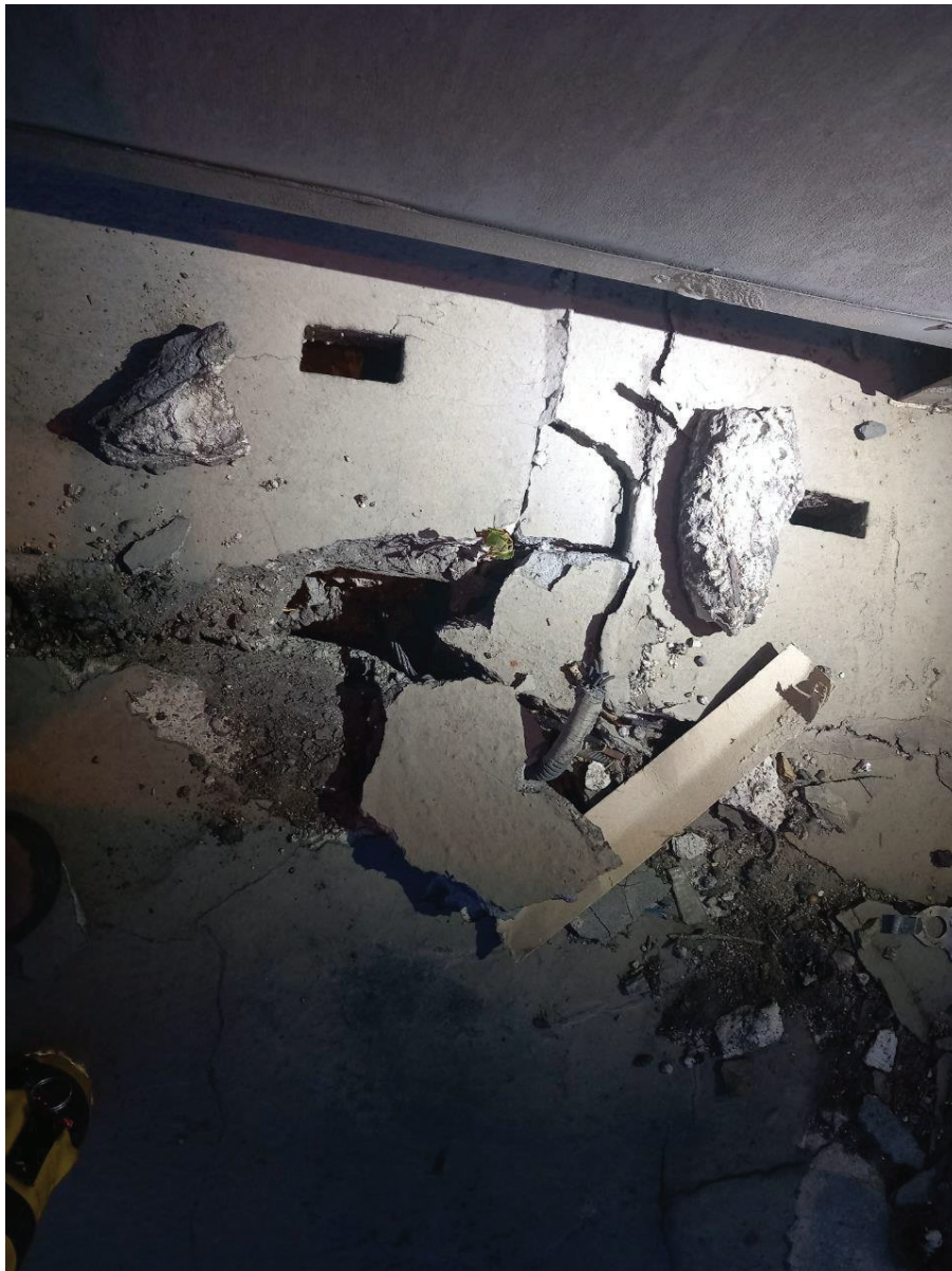
Imatge 1. Degradació de la part superior
