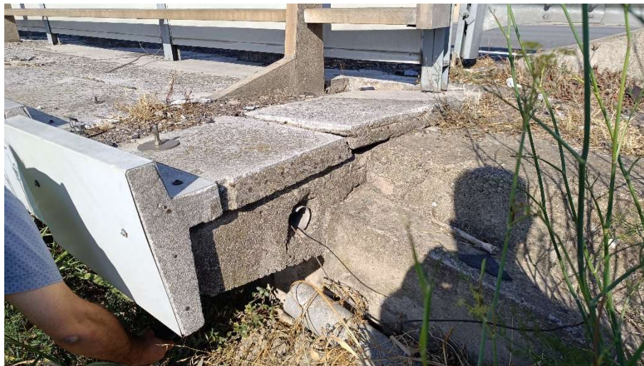
Imatge 02. Detall voladiu. Peça final amb els perns
