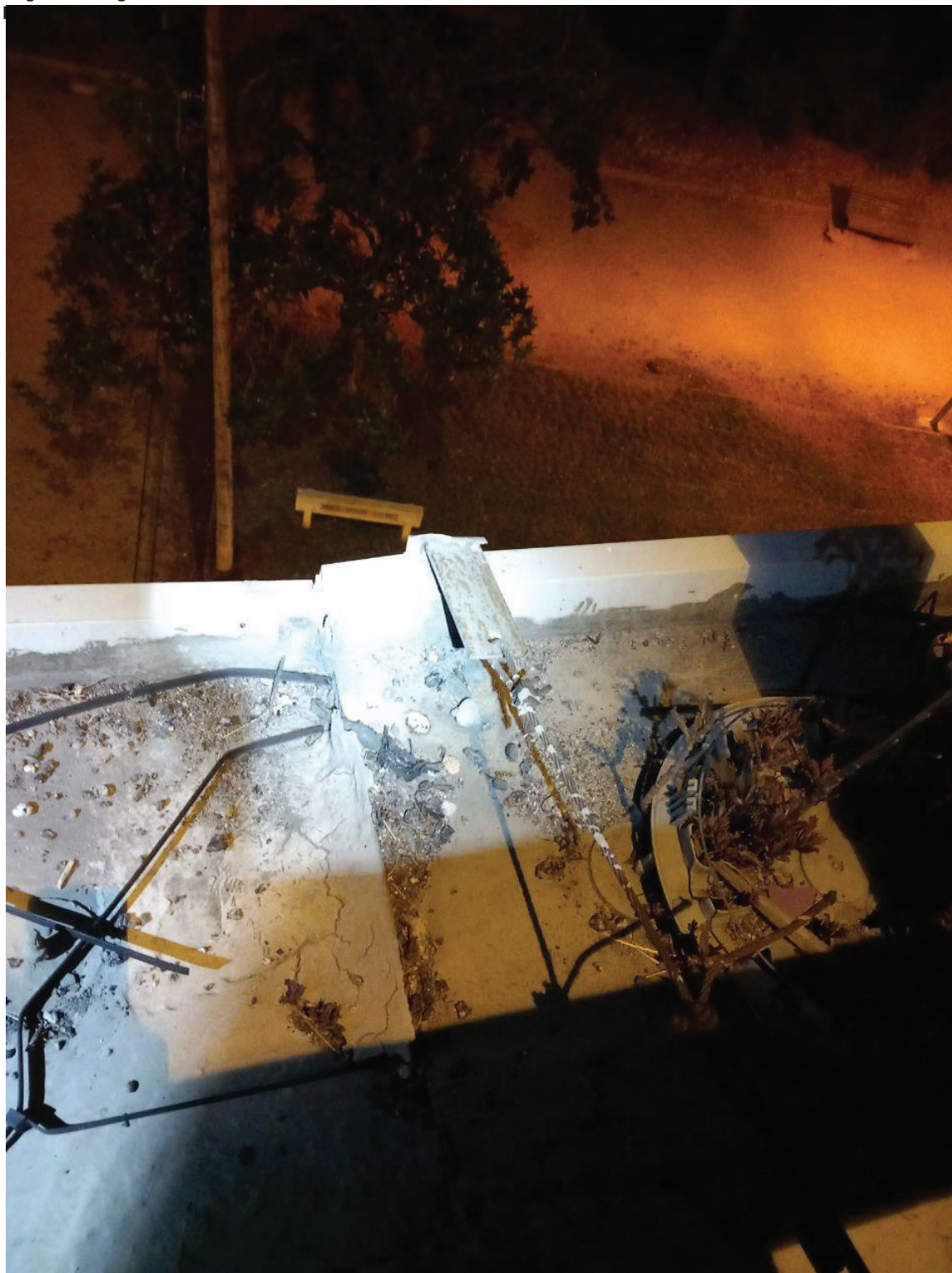
Imatge 5. Ancoratges per solventar la patologia en estat de degradació.
