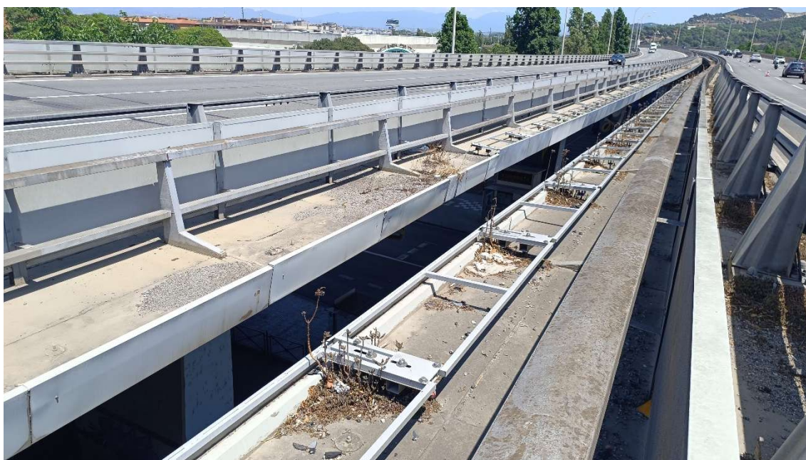
Imatge 18. Reforç estructural a les impostes
