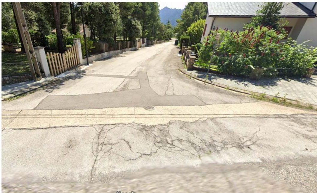
Creuament de LV4241 amb Carrer Roca Foradada
