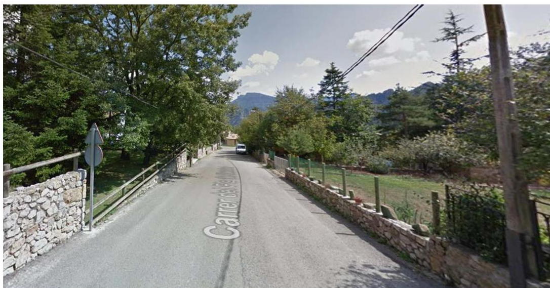
Carrer Pla de Bessies. Amb inexistència de voreres.
