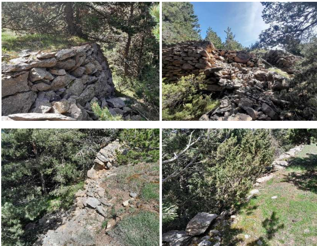
Imatge 15. Murs de pedra a reparar i/o construir.
