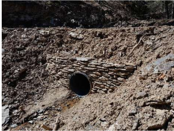
Imatge 7. Exemple de mur de pedra seca a la sortida d'un tub.
