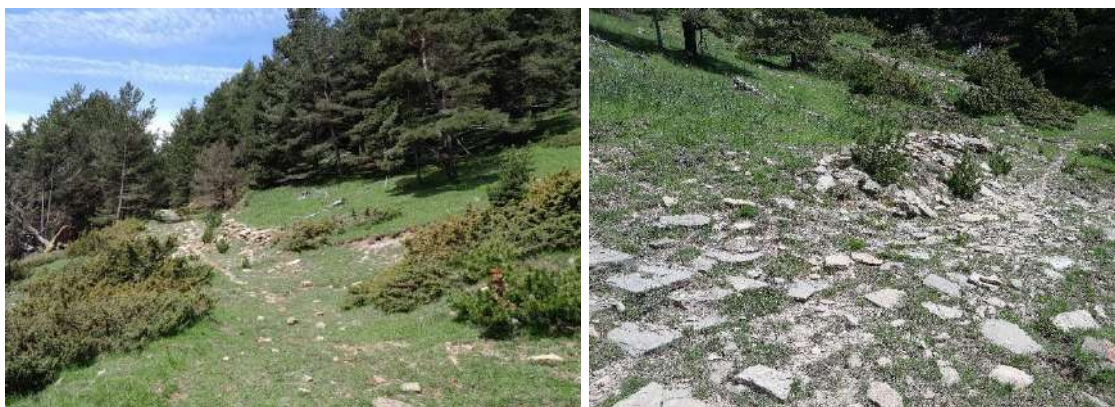
Imatge 17. Tram on cal fer moviments de terres per suavitzar la rasant (M1).
