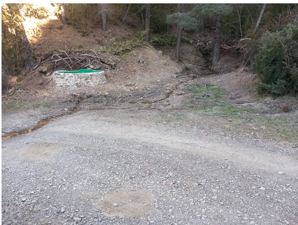
Imatge 12. Abeurador del Solà del Vedat, l'aigua sobrant malmet la plataforma de la pista.
