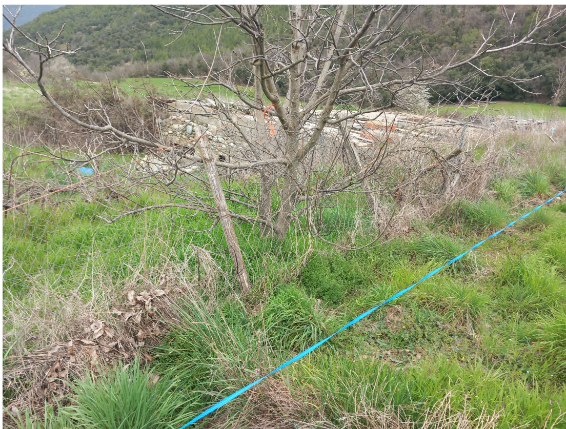
Imatge 6. Estat actual de la tanca, tombada
