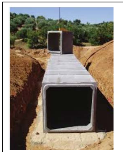
Imatge 7: Calaix de formigó en rasa. Fot. Empresa Prhormarco..
