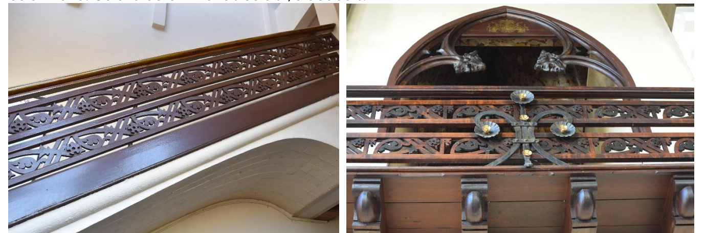
Barana estat actual
