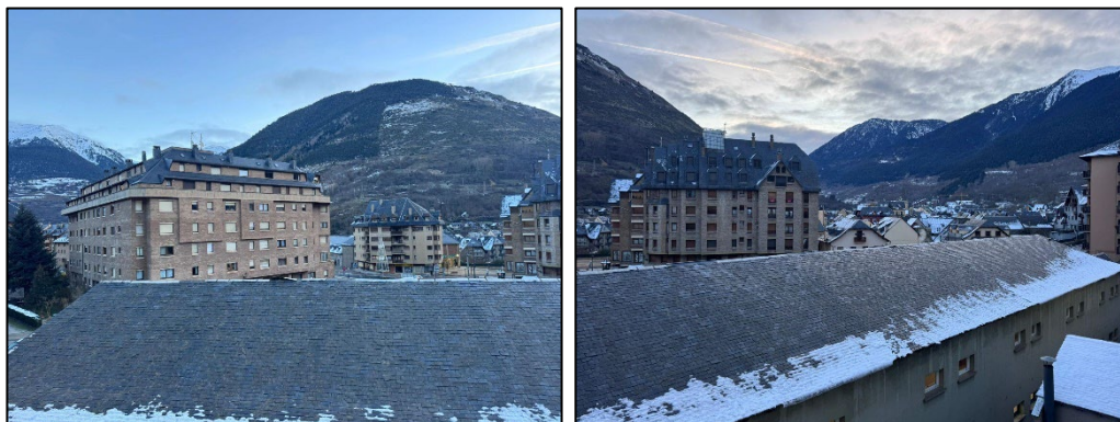
Xapes de remat de coberta deteriorats
