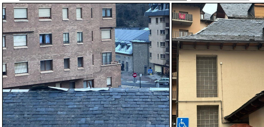
Xapes de remat de coberta deteriorats
