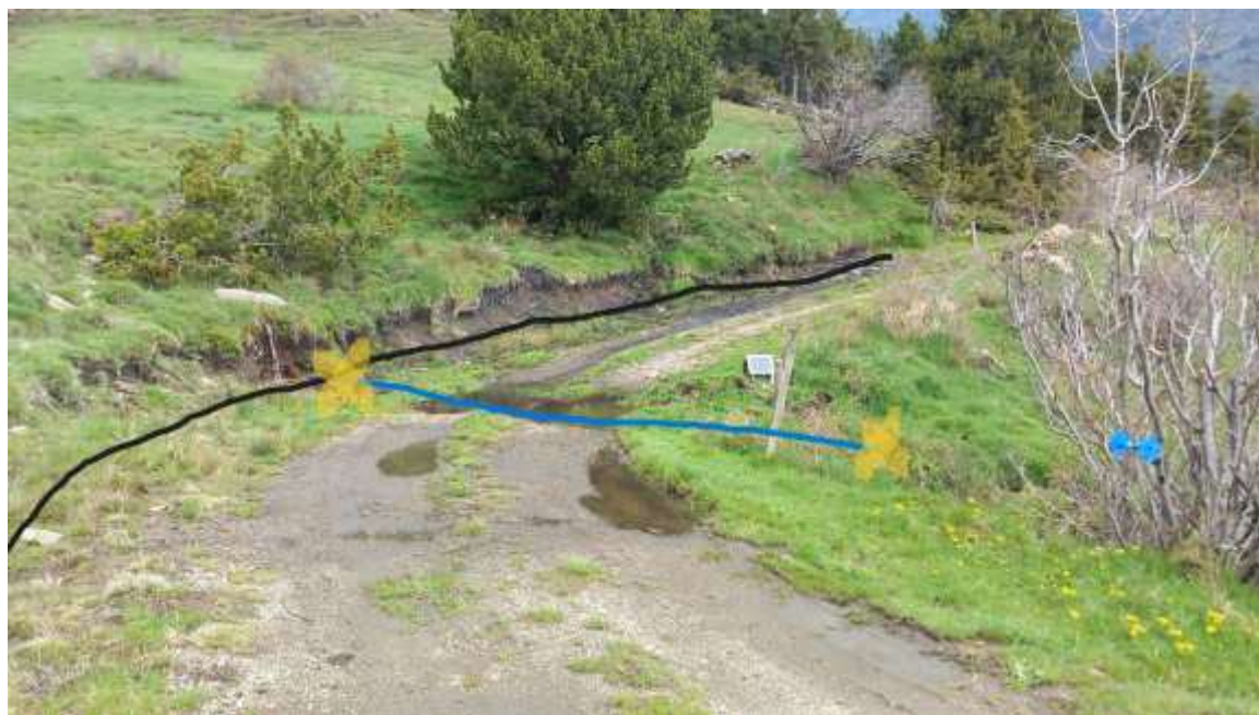
Imatge 7: Actuacions punt 1. Ratlla blava correspon al tub de drenatge enterrat transversal, línia de color negra correspon al tub ranurat perforat longitudinal. Les X corresponen al pericó unió dels tubs i emmacat al final del tub de drenatge.
