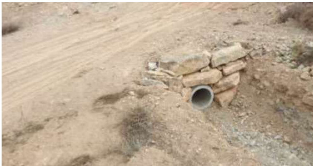
Imatge 1:Mostra d'un emmacat de pedra natural al final/inici d'un tub de drenatge transversal en una pista forestal(Font: DARPA)
