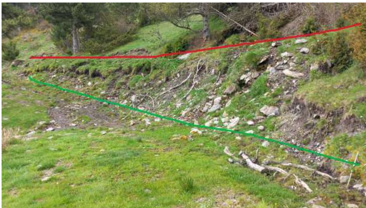
Imatge 9: Actuacions punt 2; línia vermella correspon a la millora del reg que es farà de forma manual. Al punt 3; la línia de color verd correspon a la construcció de cuneta.
