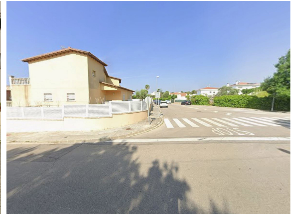
Foto 3 – reguladora sector Sant Antoni Mig (carrer del Berguedà)
