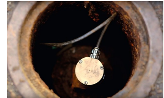
Detector de fuites tipus ORTOMAT-MTC (instal·lació dins d'arqueta existent)
