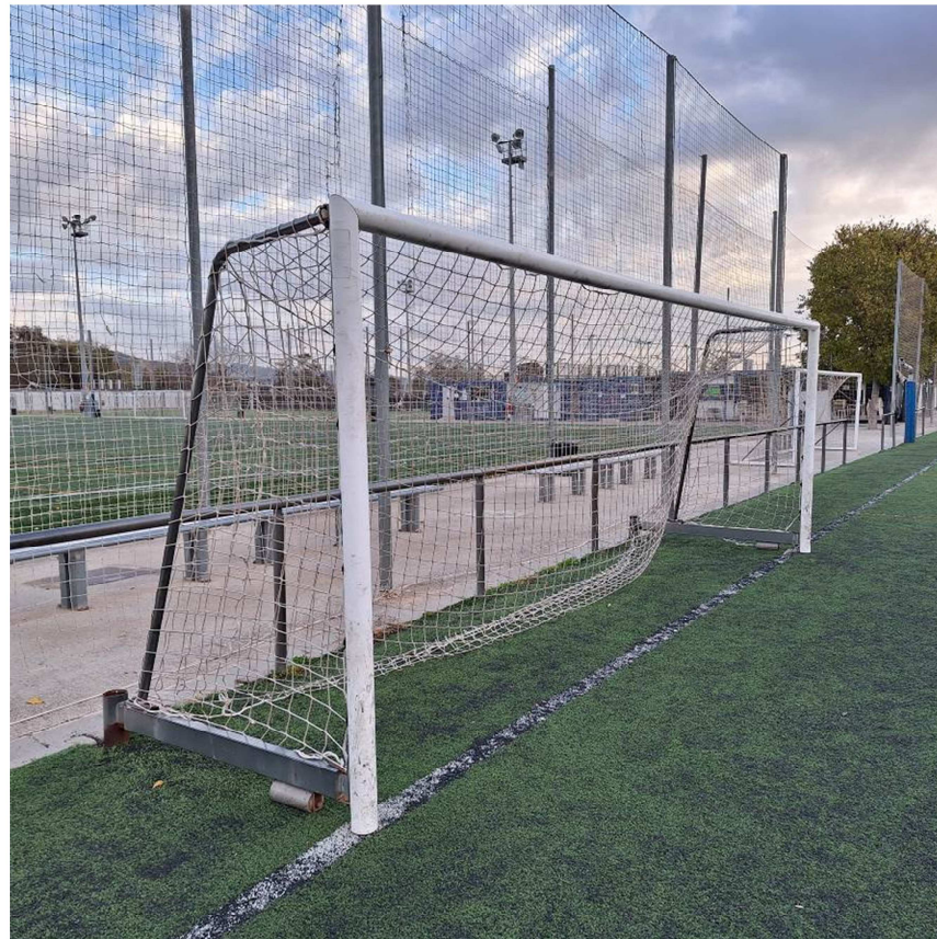
Equipament – Porteria de futbol 7. Fixacions rovellades i algunes porteries deformades
