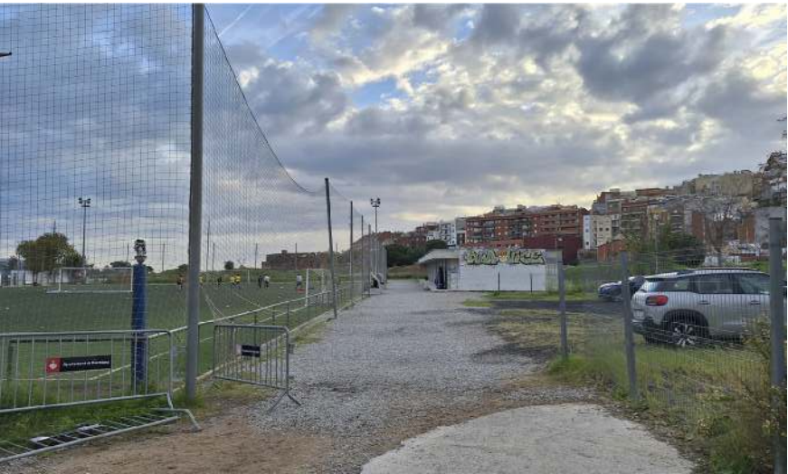
ZONA D'APARCAMENT I APLEC D'OBRA
