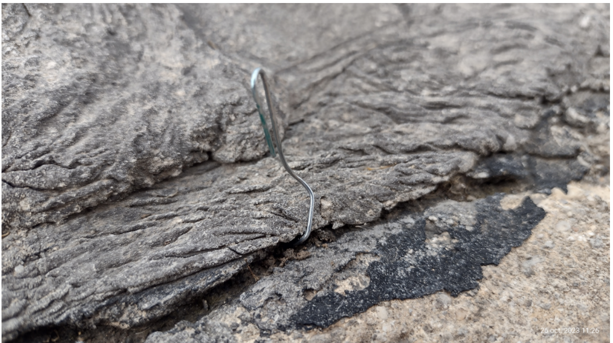
Inspecció detallada esquerra pantalla asfàltica / mur zona sobreeixidor (octubre 2023)
