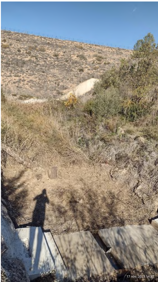
Construcció d'aforador aigües avall de la presa (novembre 2023)
