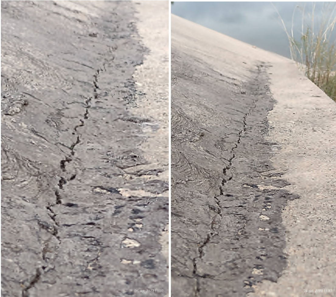
Inspecció detallada esquerra pantalla asfàltica / mur zona sobreixidor (octubre 2023)
