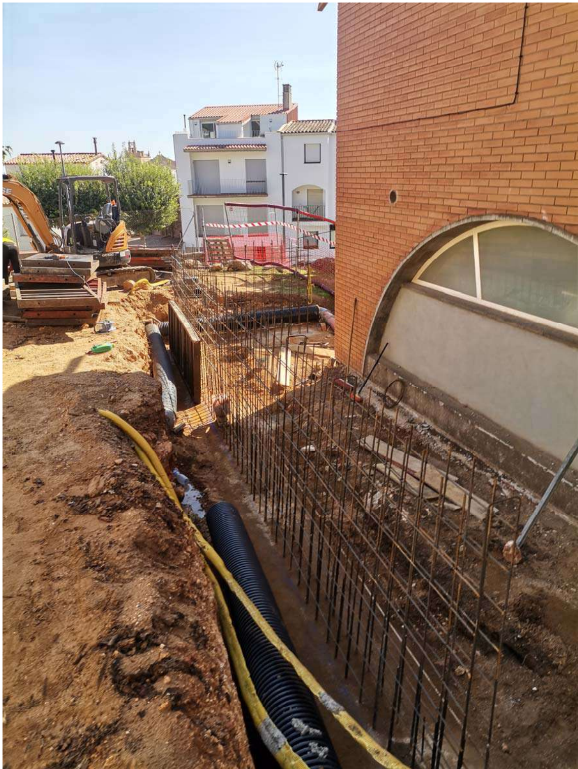
Tub de sanejament d'aigües pluvials col·locant-se (setembre 2024)
