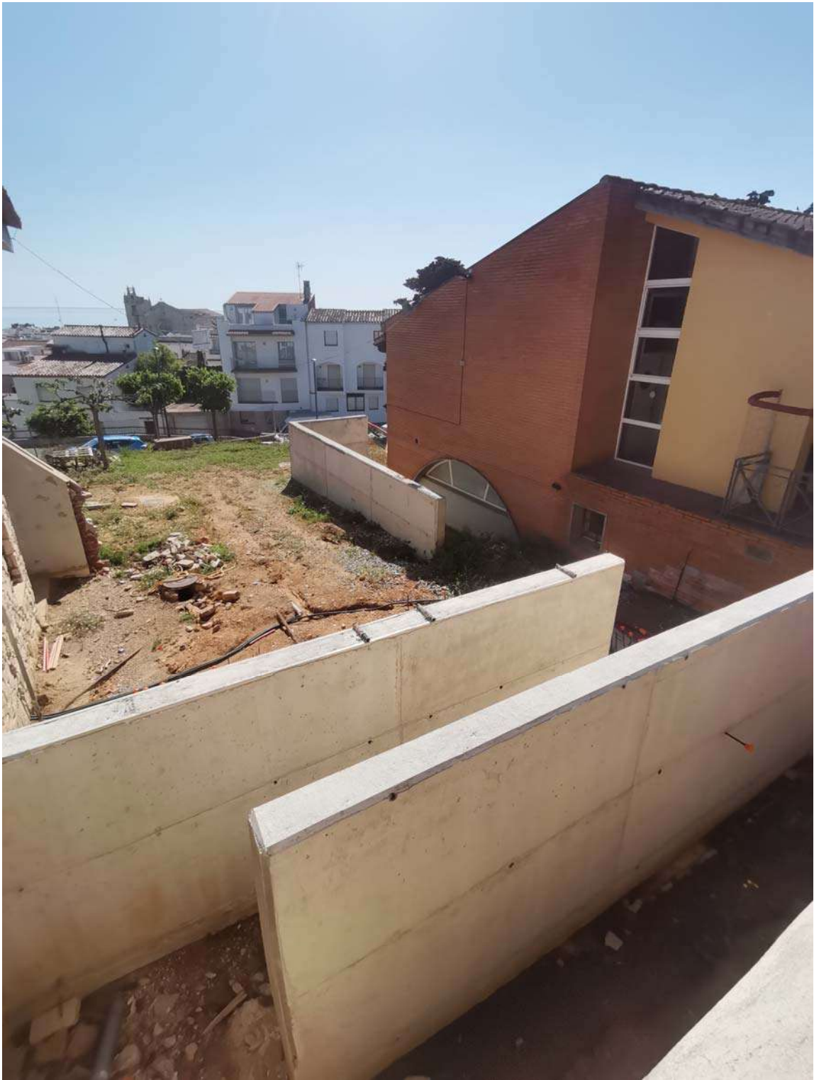
Estat actual de la construcció dels murs M1 (el de darrera li falta rematar-lo superiorment)
