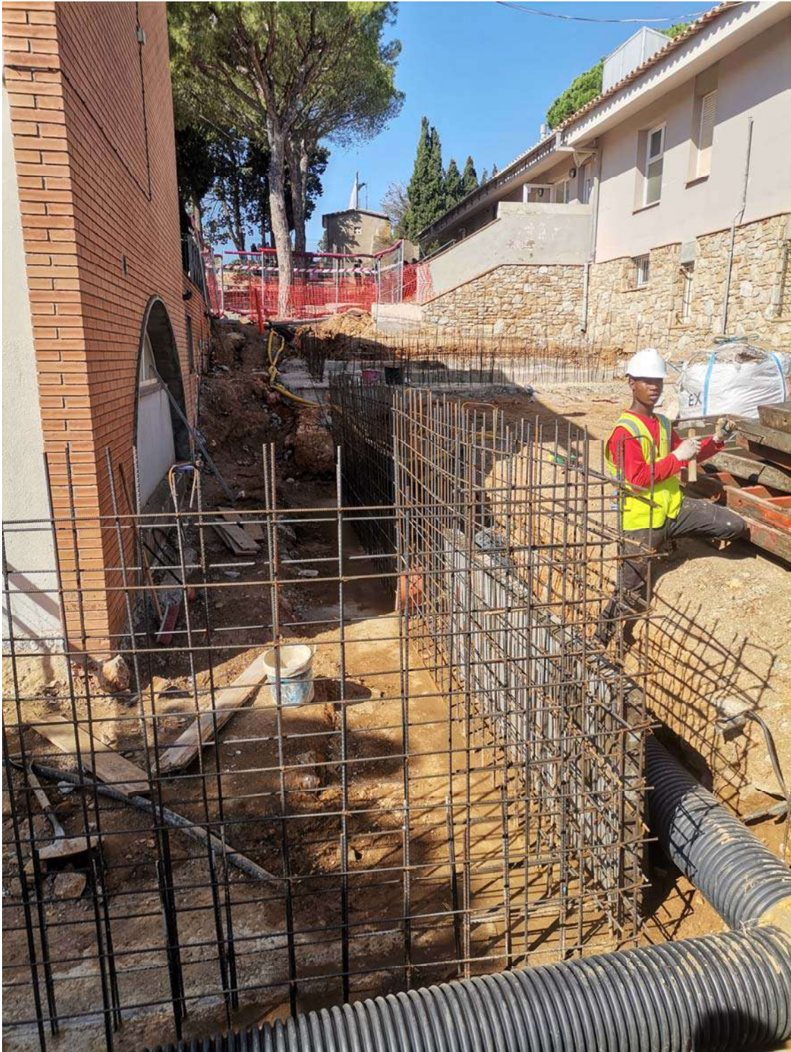
Tub de sanejament d'aigües pluvials col·locant-se (setembre 2024)
