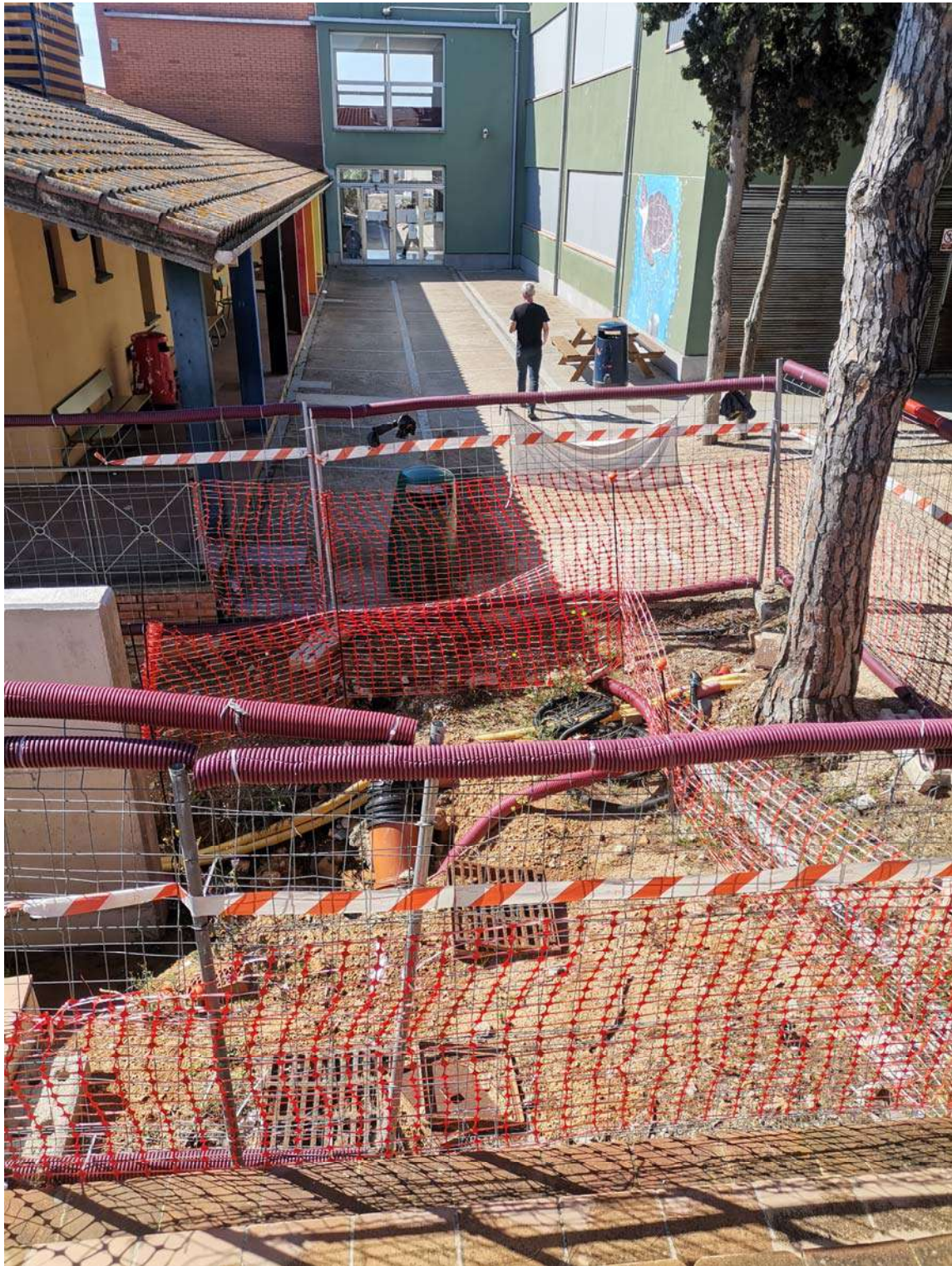
Estat actual a la zona on hi ha d'haver la connexió del desaigua d'aigües de pluja
