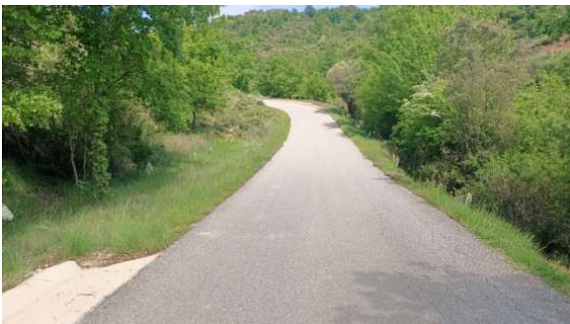
CAMÍ DEL PUJOL DE PLANÉS A GARGALLÀ MILLORA DRENATGE
