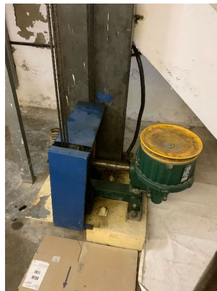
Detall del grup tractor i de la politja de reenviament.
