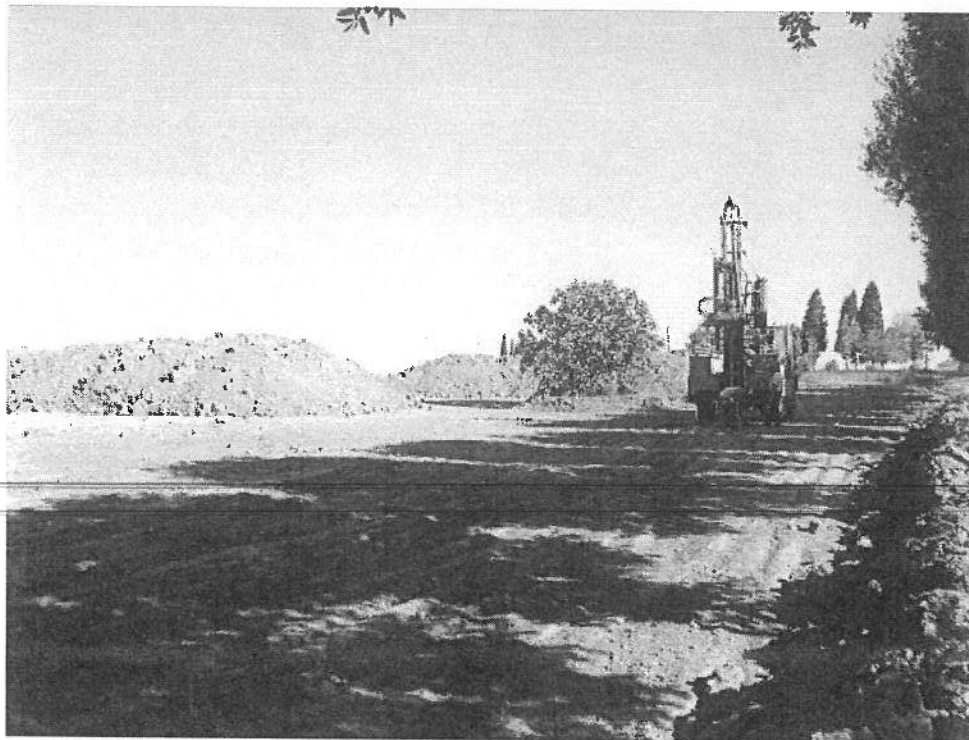
Foto 2: Vista de la parcel·la des de la avinguda Parc Tecnològic.
