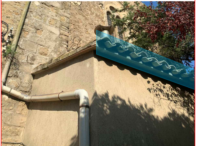
-Retir d'instal·lació pluvial existent per canonades de coure noves -Desembocant en la connexió actual -Instal·lació de canal nou de coure en les cobertes assenyalades
