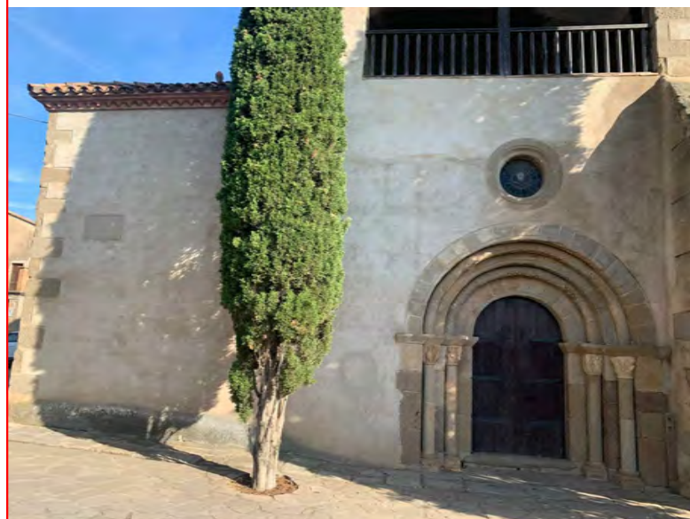
-Retir d'estuc en mal estat i col·locació de nou estuc igual a l'existent
